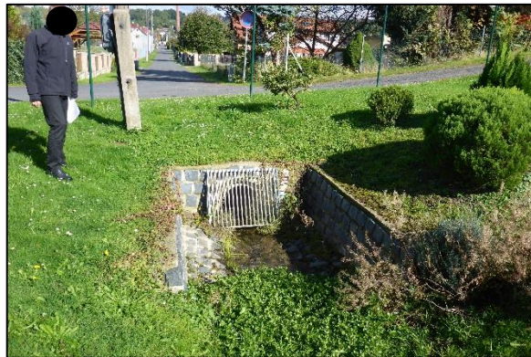
obr. 1 - Fotodokumentace údolnice přitékající do vtokového objektu zatrubnění
