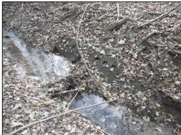
obr. 2 - Fotodokumentace nevhodné úpravy koryta toku v podobě napřímení a opevnění betonovými polovegetačními tvárnicemi (zdroj: „Analýza možností podpory hydrologických funkcí krajiny - povodí Václavického potoka“)
