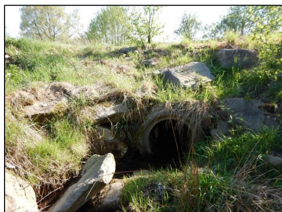
obr. 5 – propustek pro přejezdovou cestu
