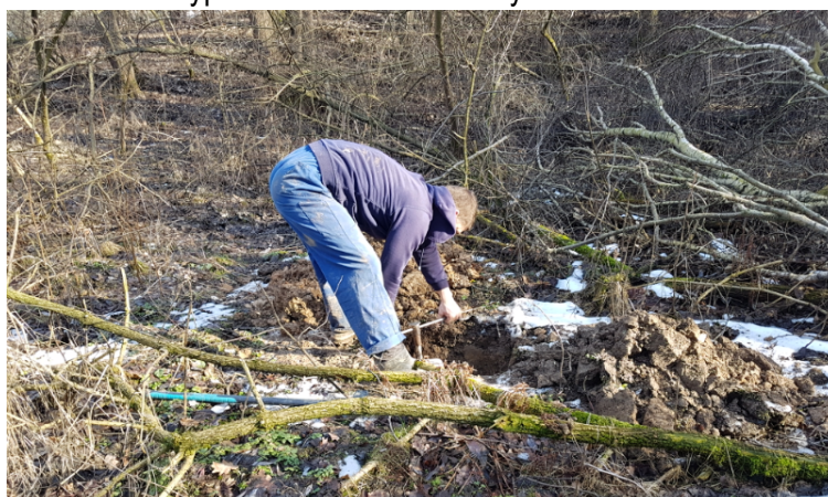
vyprošťování vrtného soutyčí z KS 3
