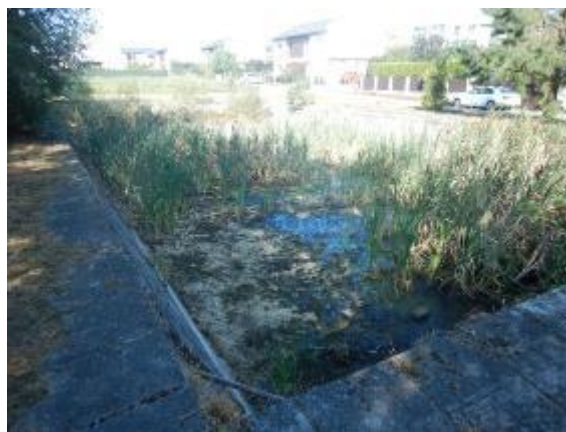
stávající požární nádrž připravená k rekonstrukci
