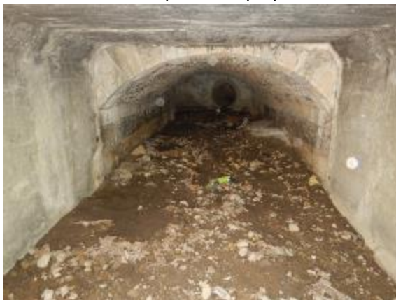
pohled na zatrubnění z dolní vody
