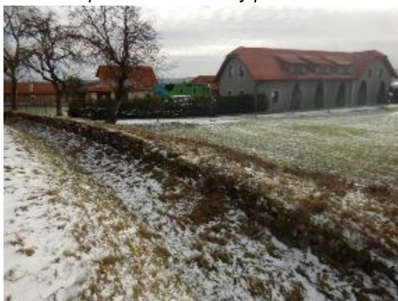
detail kapacitního silničního příkopu
