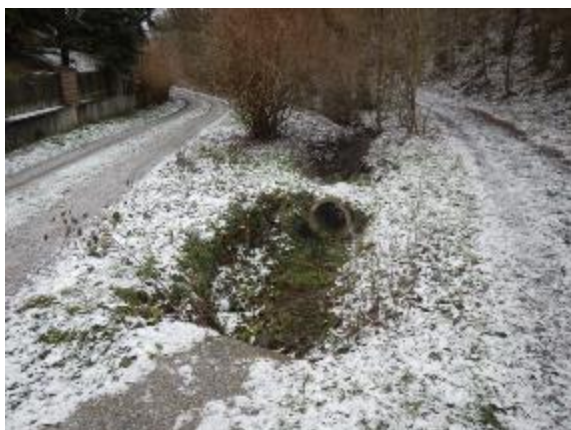
úsek toku nad zastavbou
