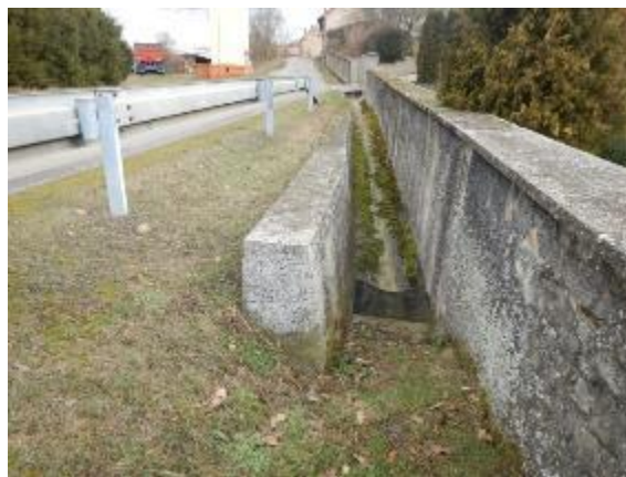
detail podchodu hlavní silnice nad KB
