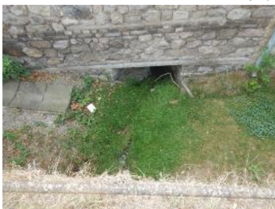
propustek pod komunikací v místě vtoku do zahrady rodinného domu
