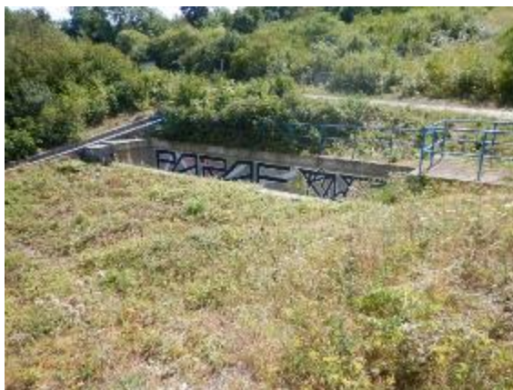
bezpečnostní přeliv nádrže
