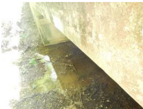
mostní objekt na hlavní silnici
