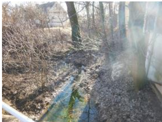
vtok do propustku
