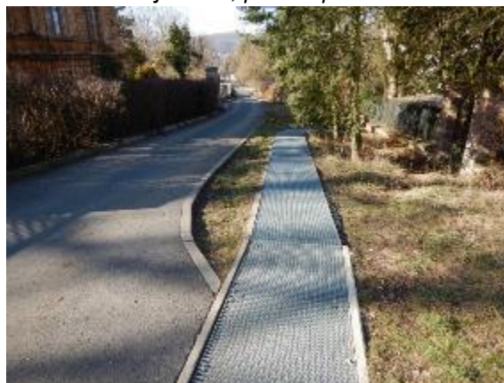
realizované odvodňovací žlaby na horním okraji zástavby (pod lesem)
