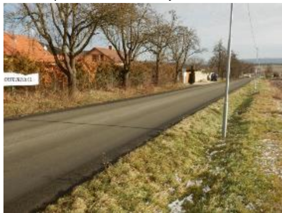
pohled na hlavní vyvýšenou komunikaci pod KB
