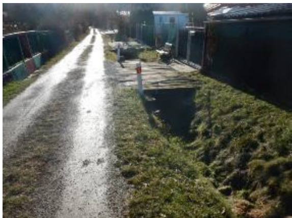
koryto vodoteče v osadě pod KB (pohled po toku)
