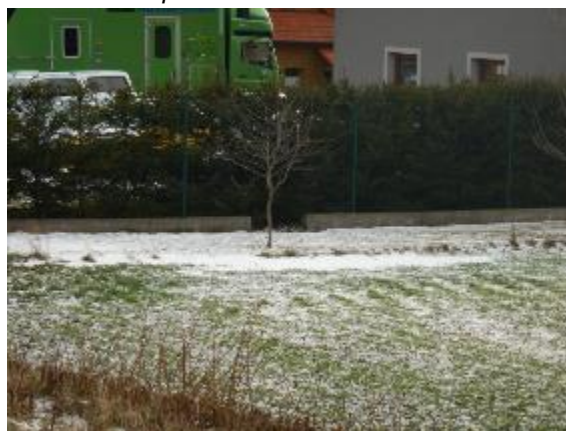
detail vyvýšené podezdívky s vynechanou částí, před plotem terénní deprese
