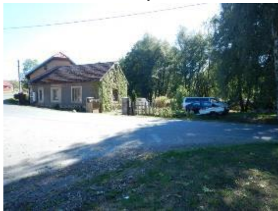
pohled na objekty nad silničním mostem
