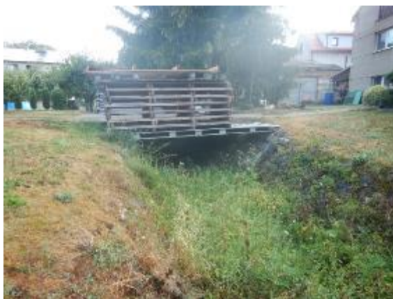
koryto toku nad silničním mostkem (pod KB)
