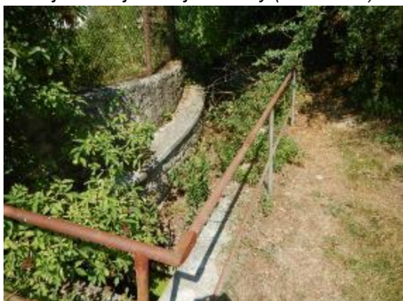
pohled na koryto nad vtokovým objektem
