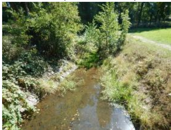
koryto pod silnicí
