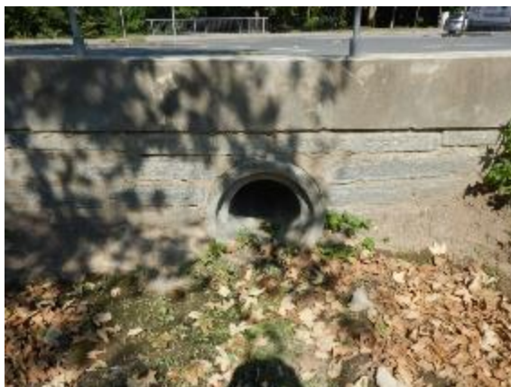
detail nekapacitního propustku
