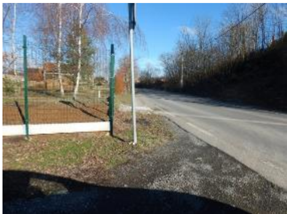
Dešťová kanalizace přes hlavní silnici
