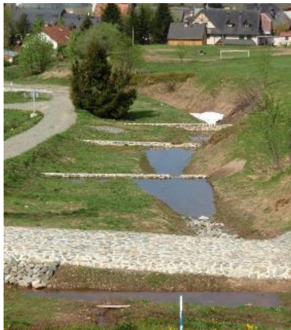
příklad kamenných hrázek nad zástavbou
