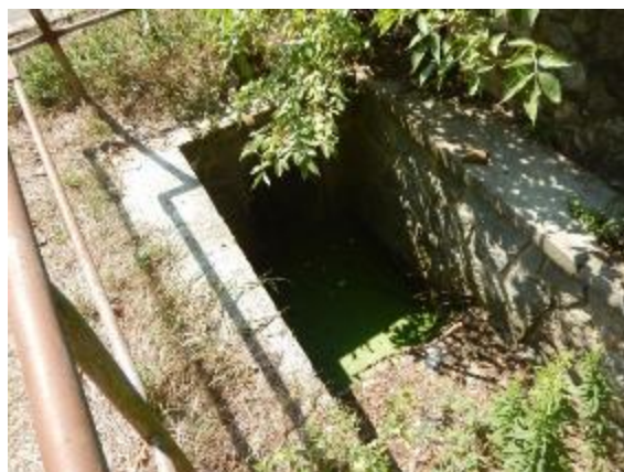
vtokový objekt do zatrubněného úseku
