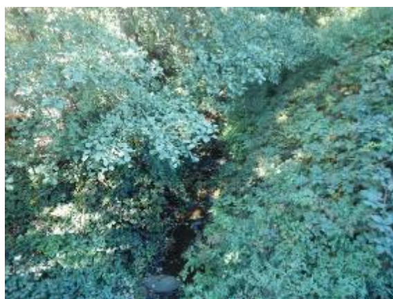
charakter koryta pod mostním objektem
