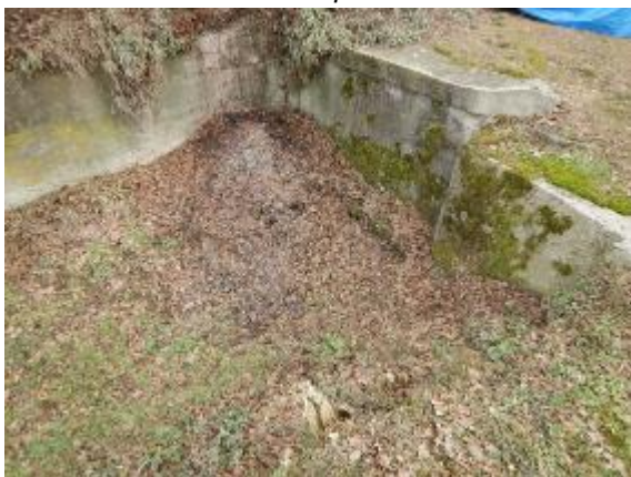
zanesený propustek v místě KB, v těsné blízkosti zástavby
