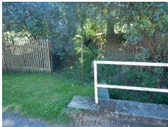
pohled na koryto nad propustkem
