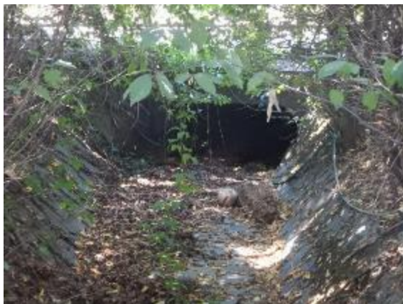
detail propustku o rozměrech cca 1.2x0.5 m
