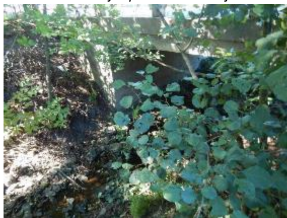
detail mostního objektu
