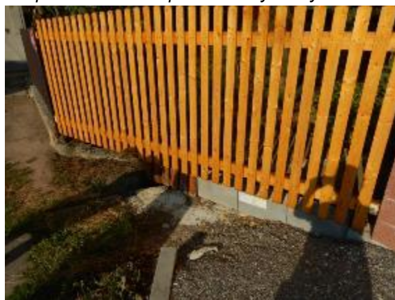
další problematické místo na odtoku vody z intravilánu obce
