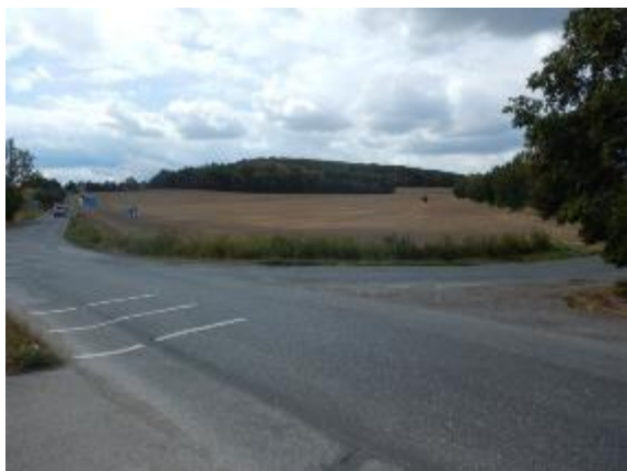
problematické místě nekapacitního (zaneseného) zatrubnění nad intravilánem
