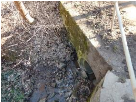
vtok do propustku
