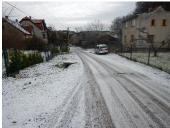
propustek pod místní komunikací
