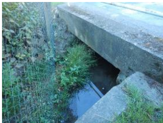
detail mostního objektu
