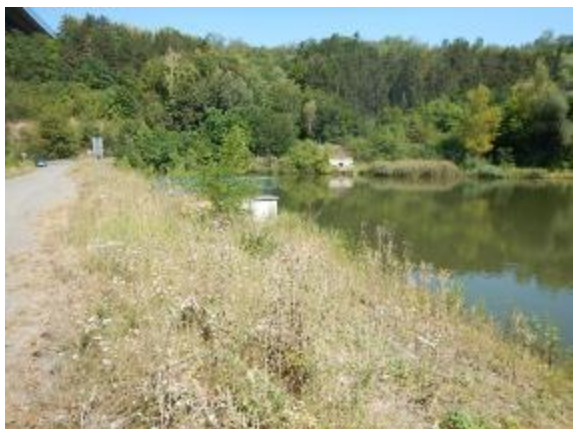
pohled na hráz stávající nádrže nad Lochkovským mostem
