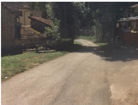
zástavba pod KB (zatrubnění pod komunikací)
