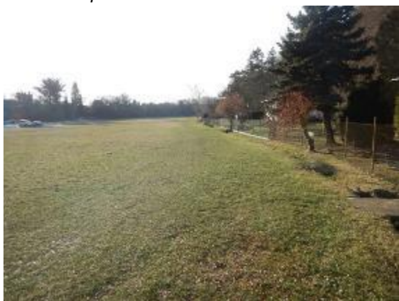
koryto v údolí vedoucí podél chat
