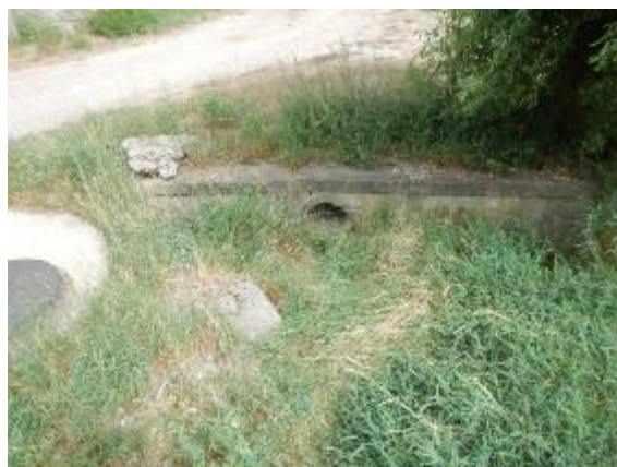
máloprofilový propustek nad křížením s komunikací
