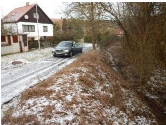
vodoteč v kritickém bodě
