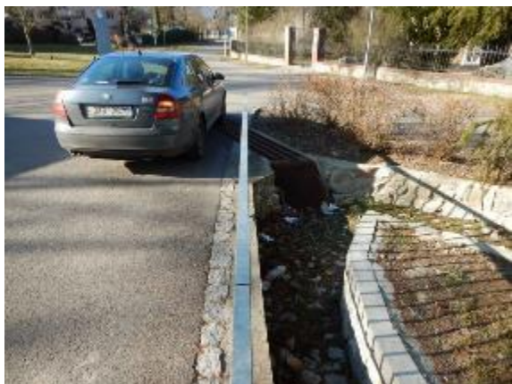
pohled na křižovatku Svážná-Krajníková, detail dešťového odvodnění
