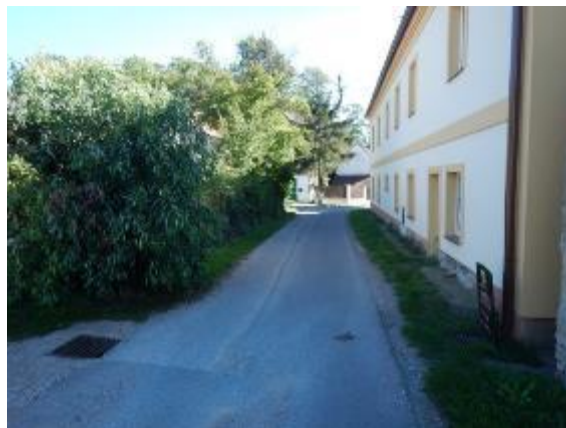
zatrubněný úsek na okraji intravilánu v místě KB
