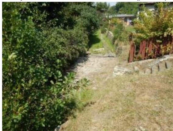
pohled na koryto toku pod silničním mostkem
