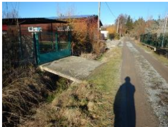
koryto vodoteče v osadě pod KB (pohled proti toku)
