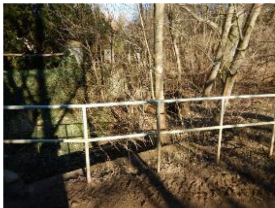
pohled SV směrem od propustku
