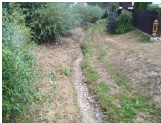
Budova pod propustkem - potenciálně ohrožená budova
