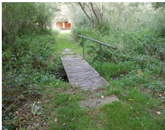
lávka v místě kritického bodu, v pozadí cesta a obytná zástavba
