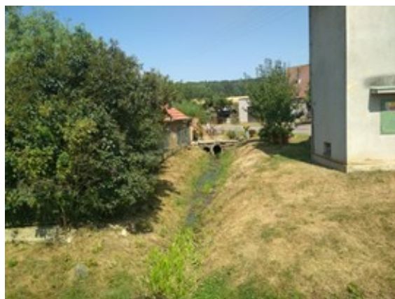
budova pod propustkem - potenciálně ohrožená budova
