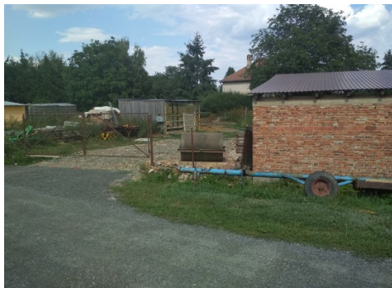
budova pod propustkem - potenciálně ohrožená budova
