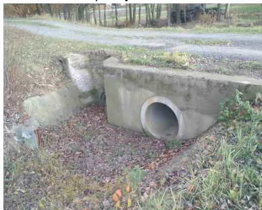
propustek bezpečnostního přelivu
