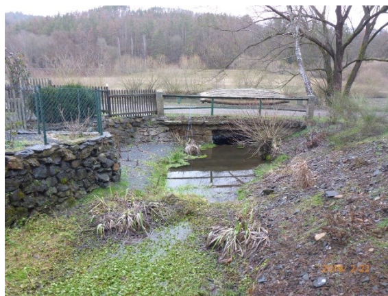
místo kritického bodu mostek, pohled po proudu
