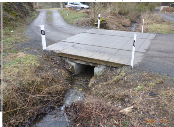
propustek pod KB
