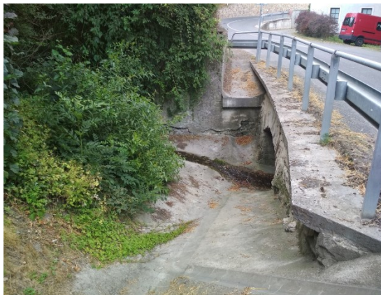
vyústění zakrytí vodního toku
