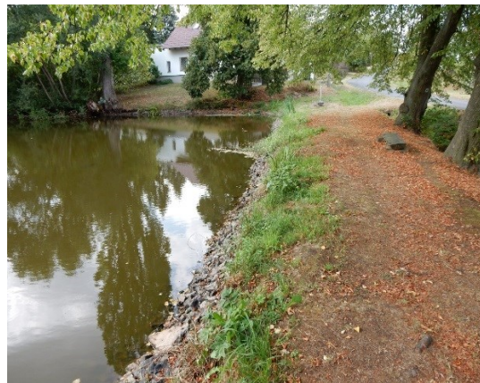
hráz malé vodní nádrže
