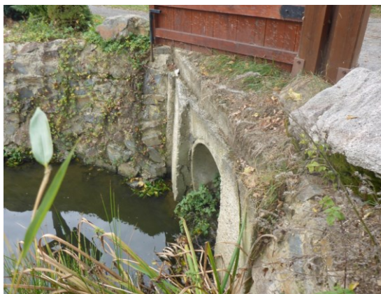
propustek pod KB
