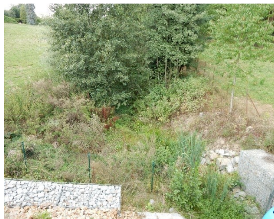
pohled na koryto v místě kritického bodu
