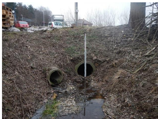
propustek z dílčího subpovodí ze západního směru
