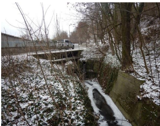
kritický bod - nátok do zatrubnění pod průmyslovým areálem
