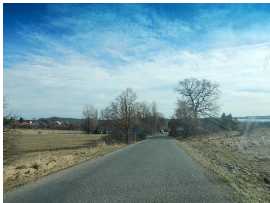
pohled na silnici a údolnici (nalevo)
