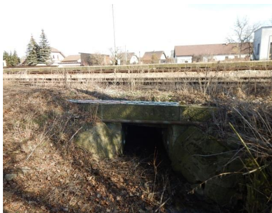
detail obdélníkového propustku
