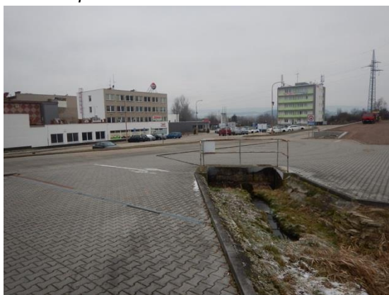
zatrubnění před areálem zpracování masa
