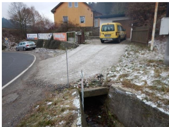
propustek pod silnicí
