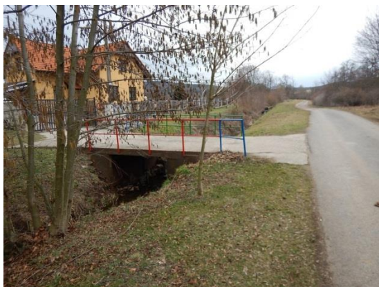
první mostek na Chlumeckém potoce na vtoku do obce Skřípel
