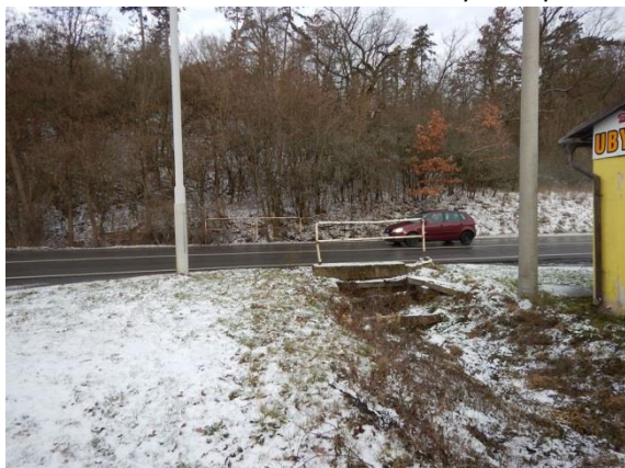
kritický bod – propustek pod silnicí
