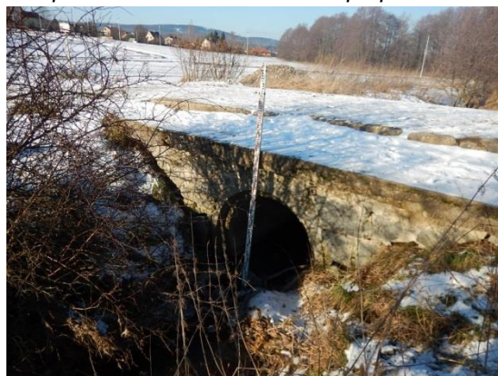
pohled na návodní stranu mostku (DN 1200)
