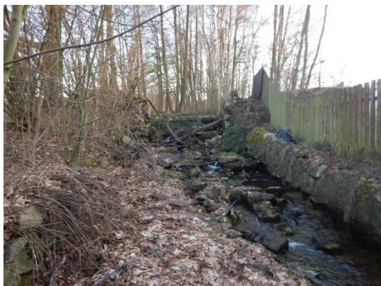
pohled proti vodě na místo kritického bodu
