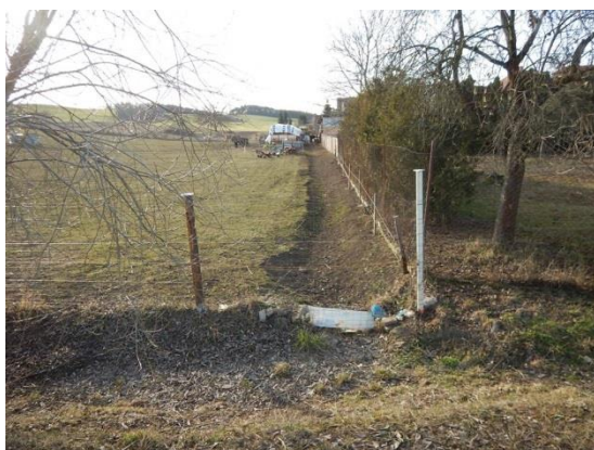
pod KB - vyschlá svodnice uprostřed údolnice
