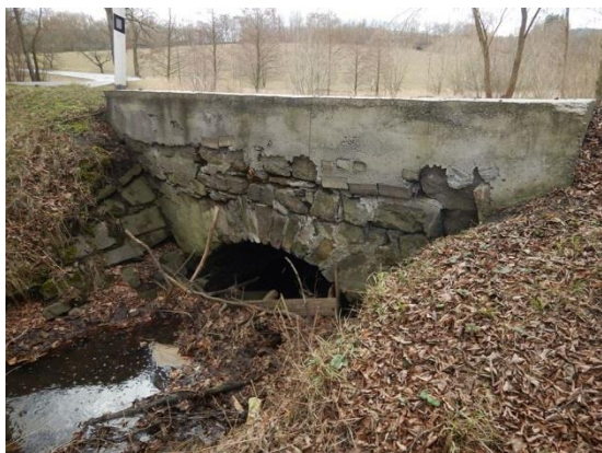
most přes Hlubošský potok na hlavní silnici
