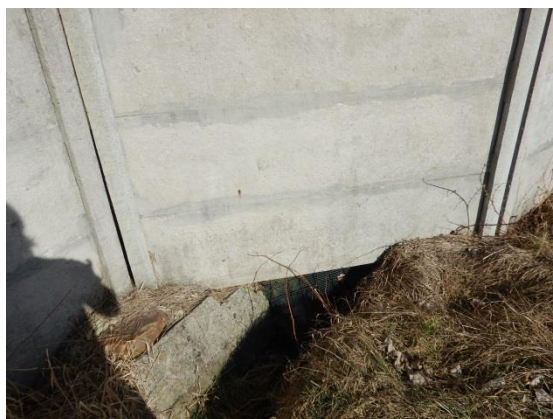
detail průchodu pod plným oplocením
