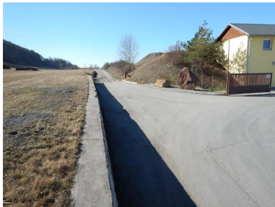
stejná silnice v horní části u soukromého areálu (silnice K Lomu)
