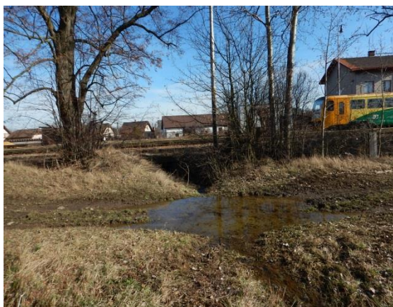
pohled na propustek pod železnici
