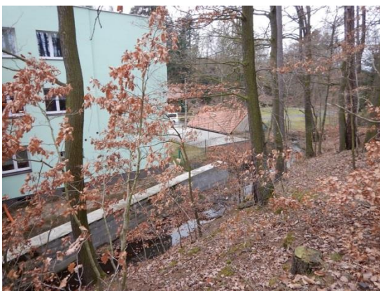
domov důchodců v těsném sousedství koryta Chumavy (pohled dále po toku)
