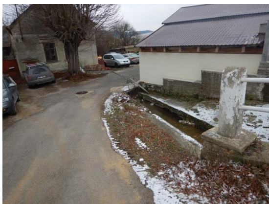
koryto pod bezpečnostním přelivem
