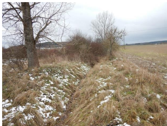
svodnice nad KB (pohled proti směru proudění)
