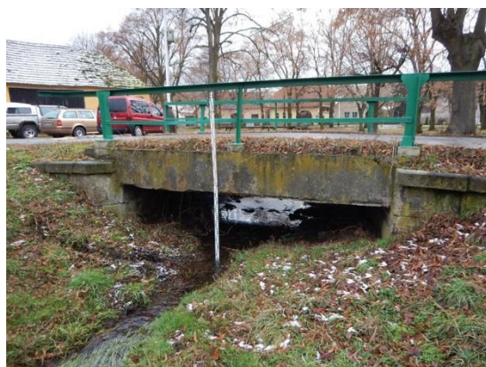
mostek přes Vraní potok - pohled po proudu
