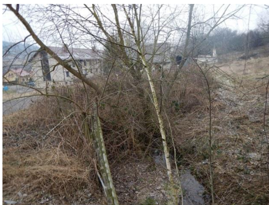
zarostlý nátok do zatrubnění svodnice
