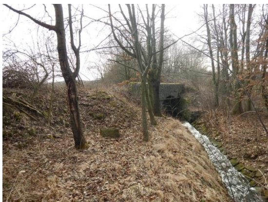
mostek nad kritickým bodem (pohled po toku Drahlínského potoka)
