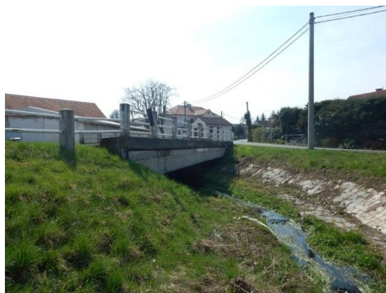
pohled na most s korytem Řeřichy - pohled proti proudu
