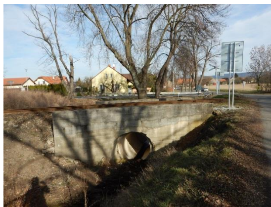
propustek pod železniční tratí (spojený odtok ze dvou svodnic)
