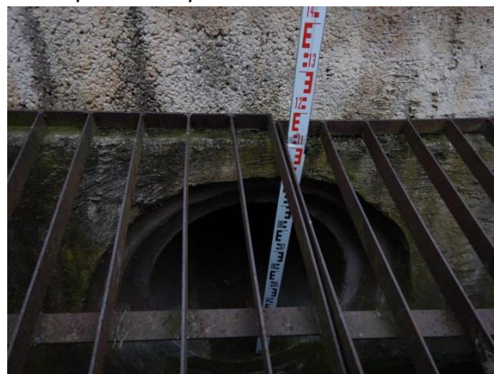
zatrubnění úseku toku za silnicí (DN 1000)
