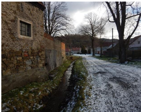
odtok z obou kritických bodů je svedený do mělkého koryta
