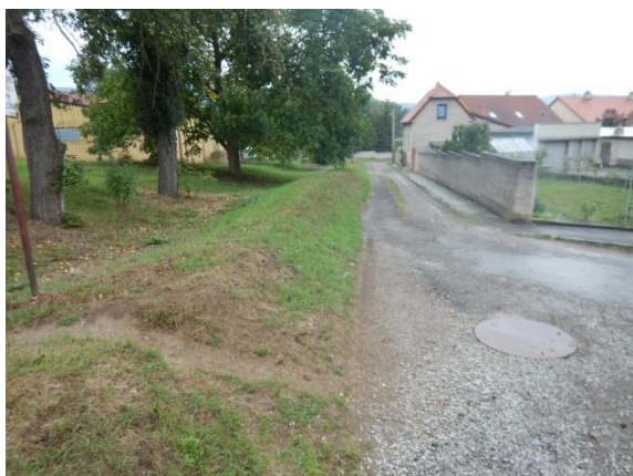
příkop a zemní hrázka nad zástavbou
