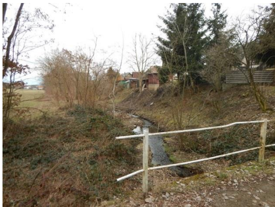
pohled z mostku s kritickým bodem po vodě
