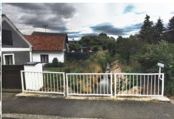
pohled z mostku proti vodě
