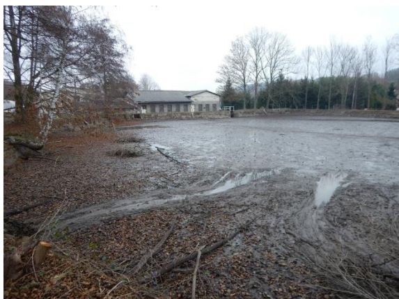
pohled na hráz rybníka
