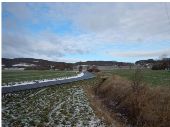
svodnice nad kritickým bodem
