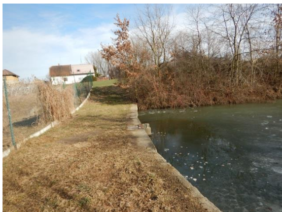
pohled na těleso hráze stávající malé nádrže
