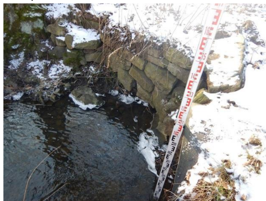
detail propustky DN 1000
