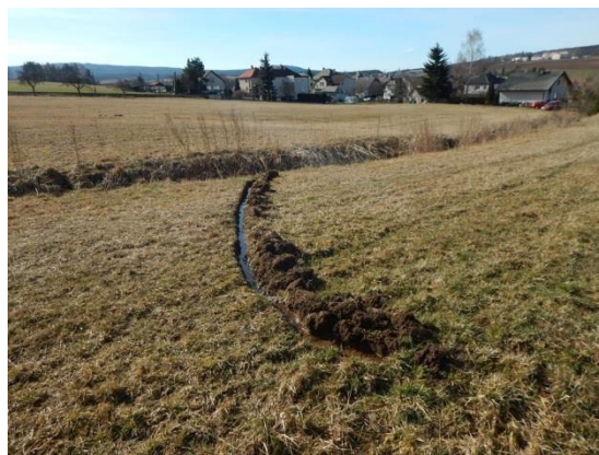
rýha odvodňující pozemek směrem do svodnice
