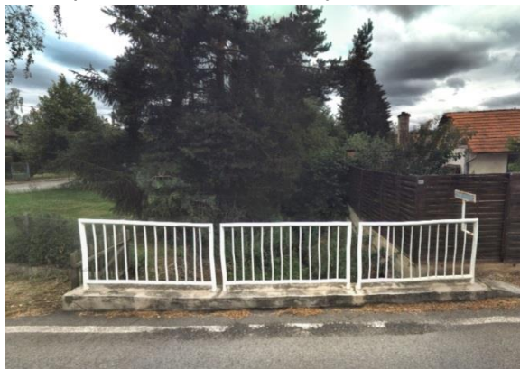
pohled z mostku po vodě
