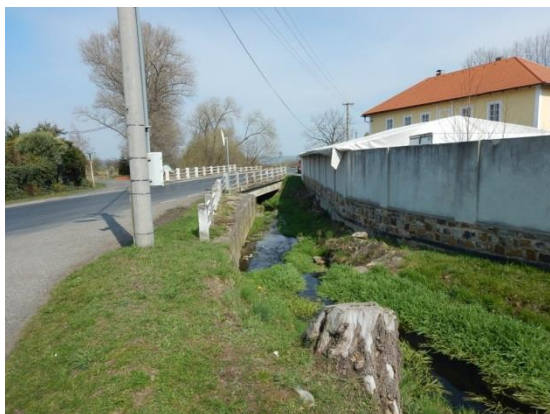
pohled na most směrem po proudu
