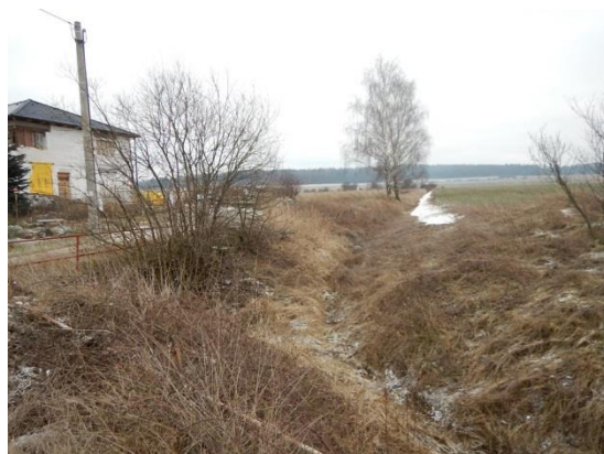
svodnice směrem k propustku (pohled proti toku)
