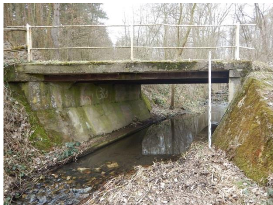
mostek s kritickým bodem, pohled proti toku
