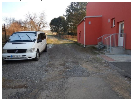
ohrožovaný areál MŠ, voda k němu přitéká s menší intenzitou i z druhé strany budovy
