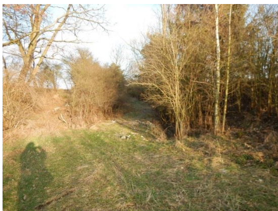
svodnice nad kritickým bodem je zapuštěná pod plochy orné půdy
