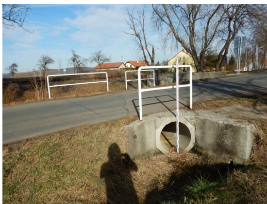
propustek u pravé (směrem po toku) ze dvojice svodnic pod místní kominkací
