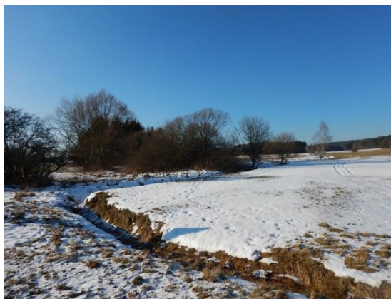
pohled na svodnici nad kritickým bodem
