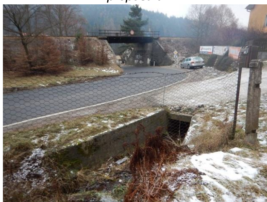
propustek pod silnicí
