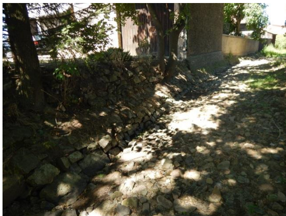
detail koryta v těsné blízkosti zástavby
