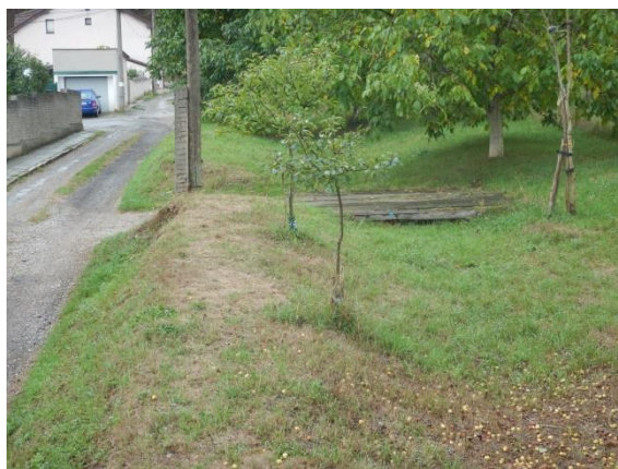
příkop, hrázka v dolní části území
