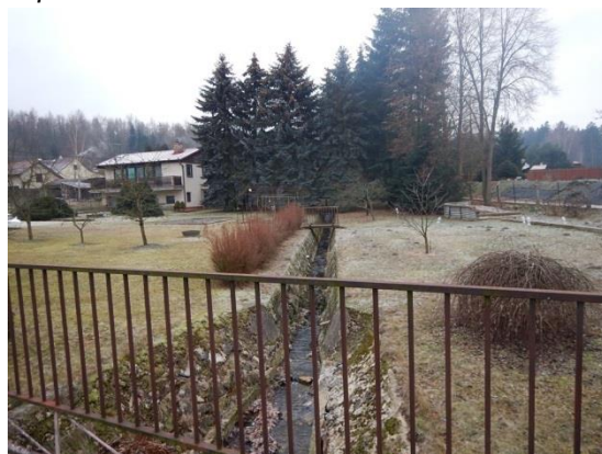
opevněné koryto v obci pod kritickým bodem
