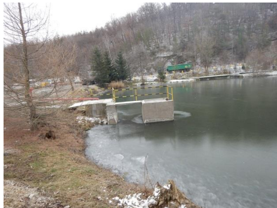
vypouštěcí objekt nádrže
