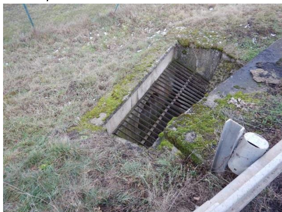
zatrubnění úseku toku za silnicí
