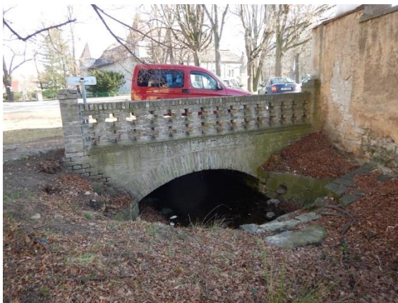
vtok do zakrytého úseku pod hlavní komunikací v obci
