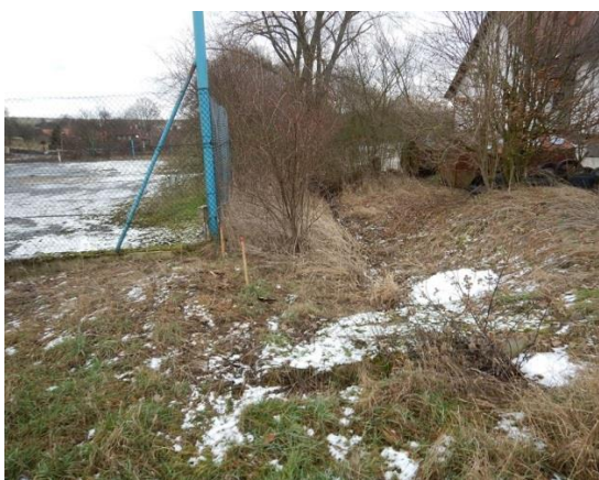
pohled na místo kritického bodu (svodnice vteká do intravilánu Trubína)
