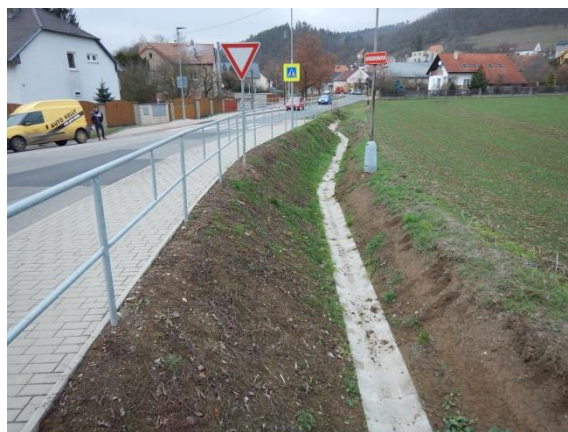
svodný příkop nad zaústěním do Diběřského potoka
