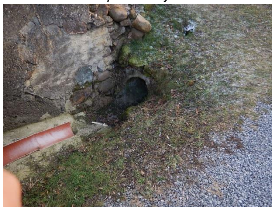
detail zatrubnění (cca DN 250)
