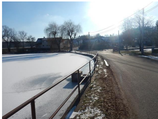
hráz prvního návesního rybníku tvoří hlavní komunikace skrz obec
