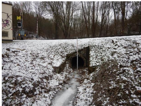
propustek pod železniční tratí (pohled proti vodě)
