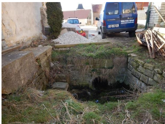
pohled na nátok do zatrubnění
