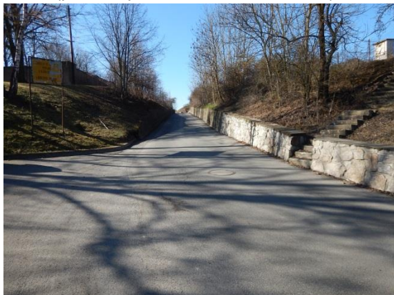
pohled na komunikaci směrem od KB, vlevo odbočka ke hřbitovu
