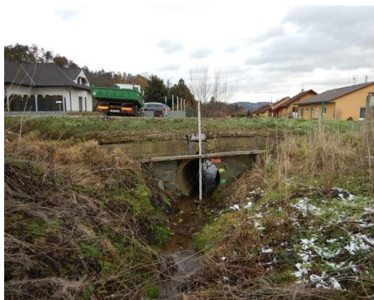
propustek DN 1000 v místě KB s vyznačenými značkami stupňů povodňové aktivity
