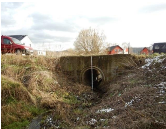
pohled na propustek v místě KB (DN 1400)
