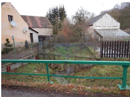
pod kritickým bodem - mostek přes Vraní potok
