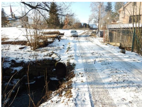
KB - propustek DN 1000 pod místní komunikací
