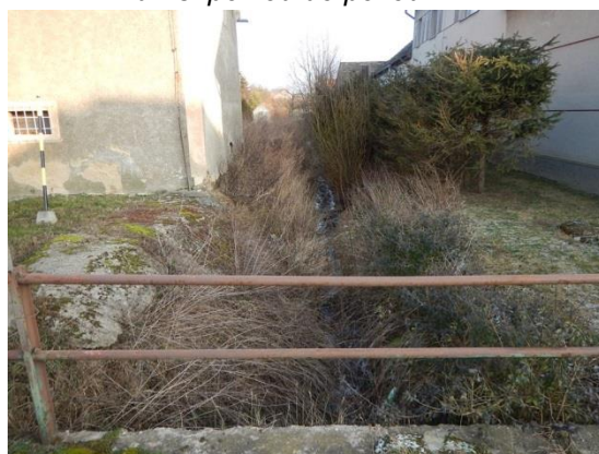
koryto pod KB u hlavní silnice v obci (pohled proti vodě)
