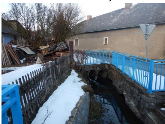
charakter toku pod kritickým bodem (pohled z mostku proti proudu)
