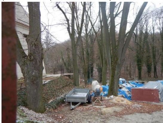
pohled skrz bránu na místo kritického bodu na Suchomastském potoce
