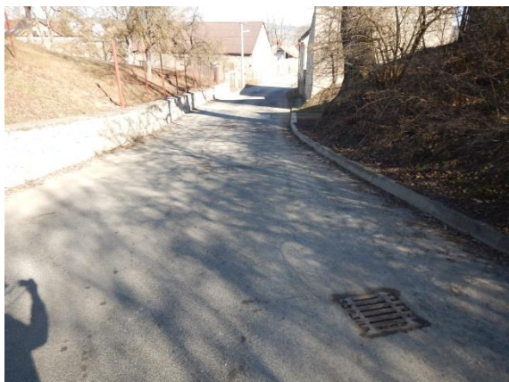
komunikace těsně nad zástavbou v KB (patrné vpusti dešťové kanalizace)
