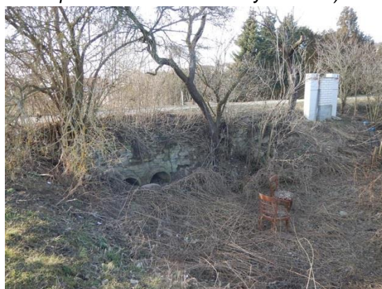
cesta s propustkem pod kritickým bodem (vyschlá svodnice dále po směru toku)
