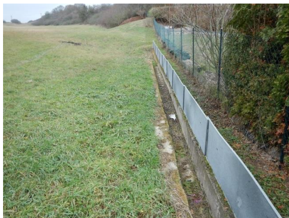
stávající ochranný prvek nad zástavbou
