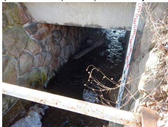
odtok z bezpečnostního přelivu
