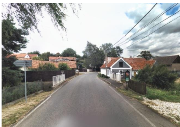
pohled na most s kritickým bodem
