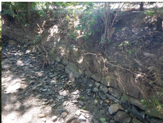
detail koryta (pravý břeh)
