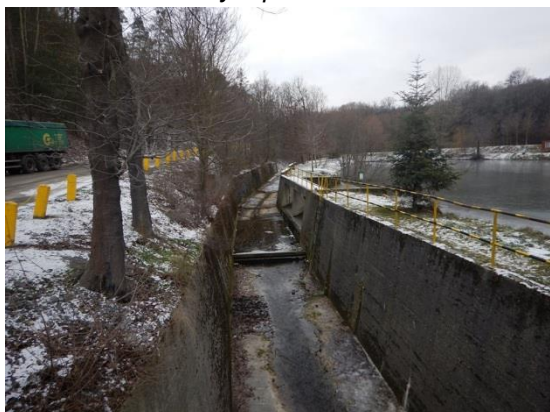
koryto Suchomastského potoka pod nádrží (pohled proti vodě)
