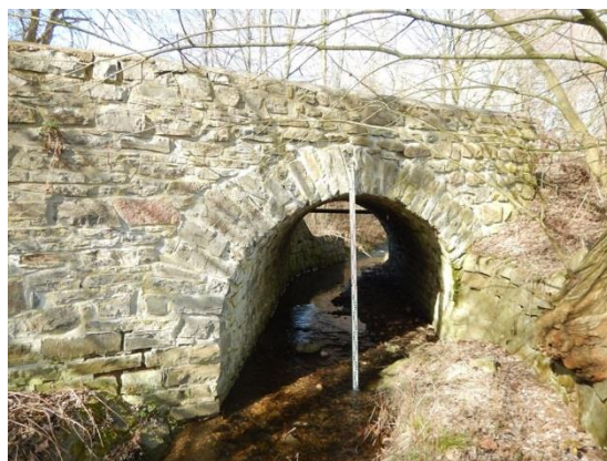
mostek (pohled proti toku)
