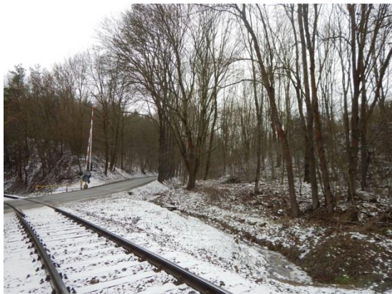
svodnice před kritickým bodem (pohled proti vodě)
