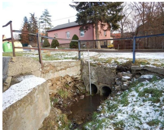
hlavní silnici místní části Levín protéká vodoteč dvěma propustky DN 600
