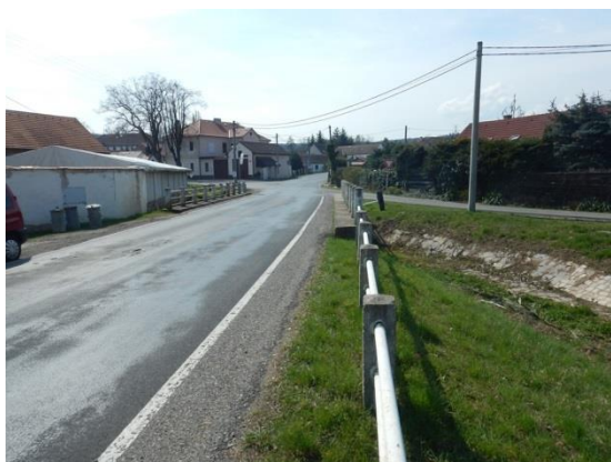
kritický bod - most přes silnici u výjezdu z obce
