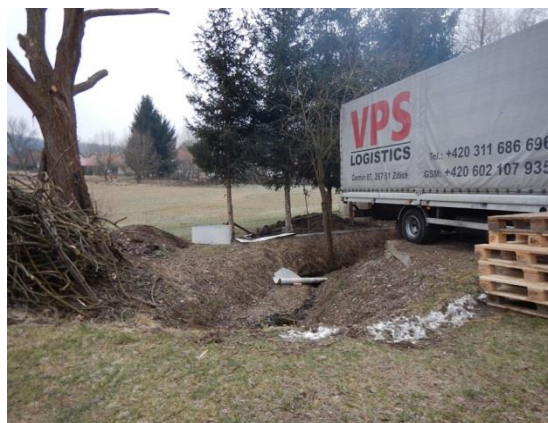
svodnice před kritickým bodem
