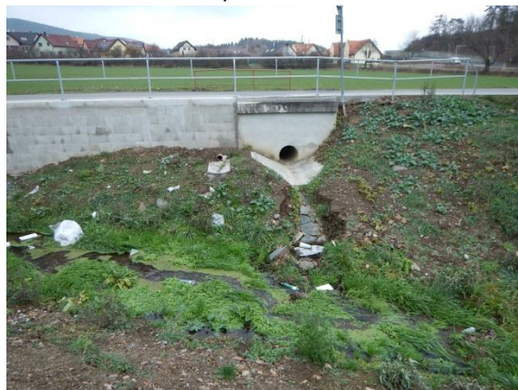
detail zaústění do potoka
