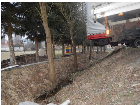
svodnice před kritickým bodem (detail)
