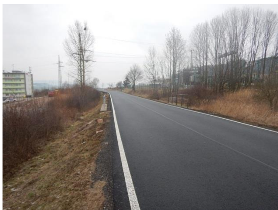
silnice s přemostěním drobného vodního toku
