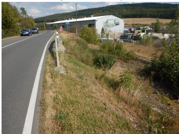
pohled na území pod silnicí II/605
