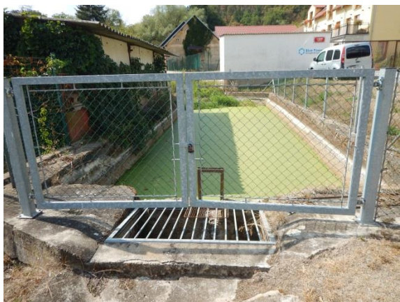
pohled na obecní nádrž před vtokem do zatrubněného úseku v intravilánu obce
