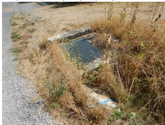
detailní pohled na vtokový objekt
