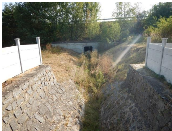
pohled ve směru toku na odtoku z bezpečnostního přelivu, v pozadí křížení s dálnicí D6
