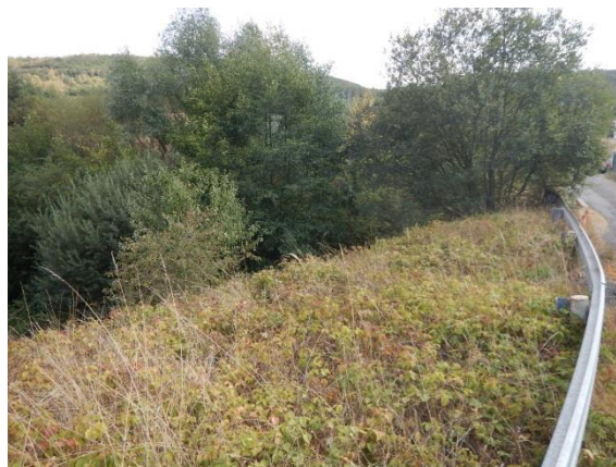
vpravo vysoký násep komunikace, vlevo hluboké údolí potoka
