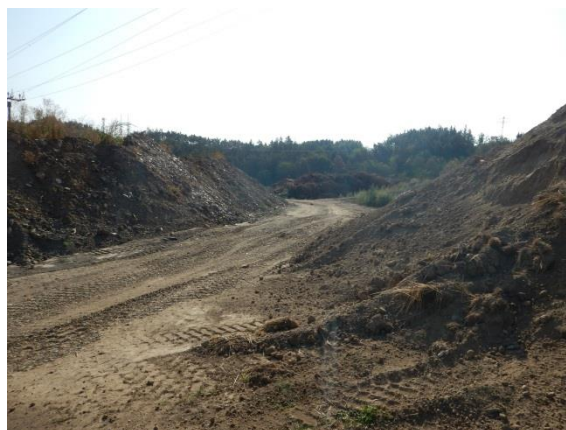
skládka materiálu nad cihelnou
