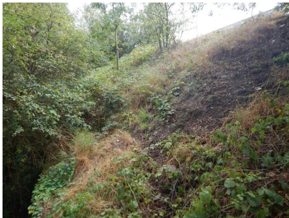
pohled na vysoký násep komunikace z údolí
