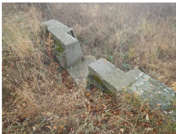
detail bezpečnostního (?) přelivu
