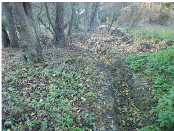
pročištěné koryto v dolním úseku
