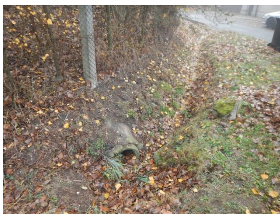
detail jednoho z propustků podél silnice
