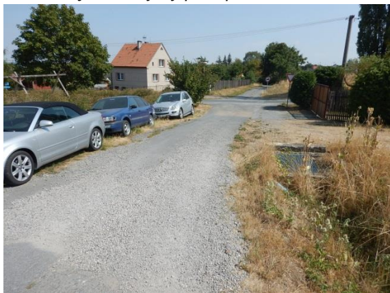
pohled podél příkopu opačným směrem
