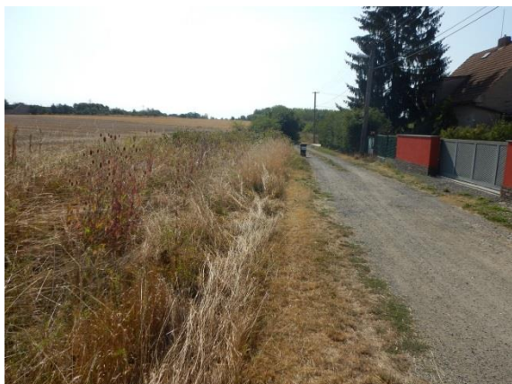
pohled na záchytný příkop se zemním valem nad zástavbou Svárova
