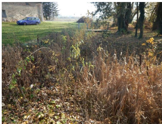
koryto pod přelivem
