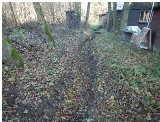
pročištěné koryto v dolním úseku
