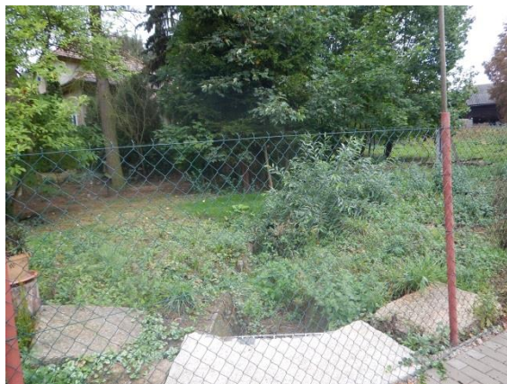
pohled na koryto nad vtokovým objektem
