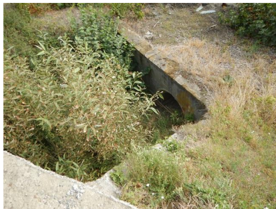
propustek menší kapacity v území pod hlavní silnicí
