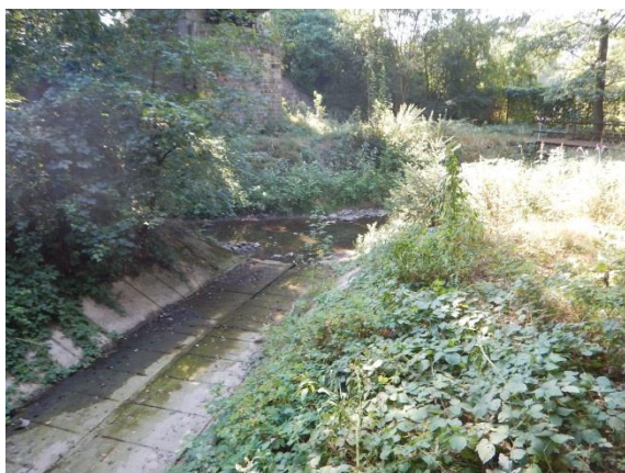
koryto vodoteče před zaústěním do Loděnice
