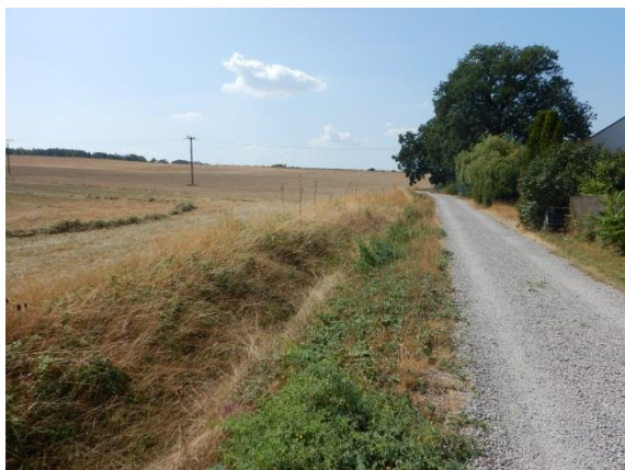
stávající zachytňový příkop nad zástavbou
