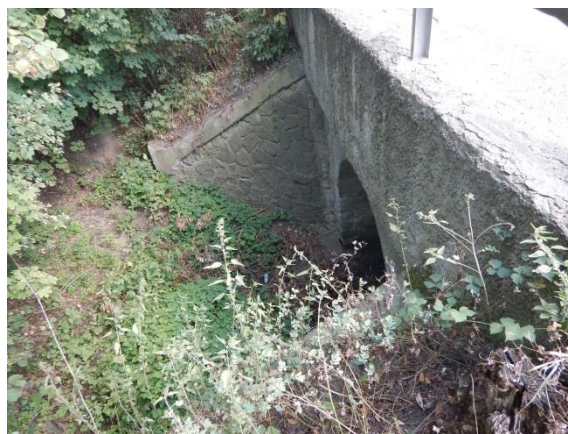
kapacitní propustek pod silnicí II/605
