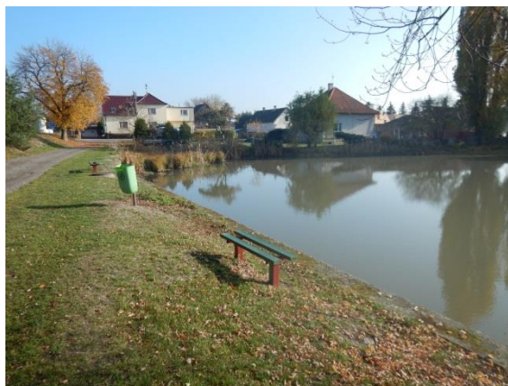
pohled na hráz rybníka
