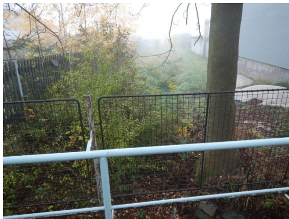
pohled na koryto toku pod hrází rybníka
