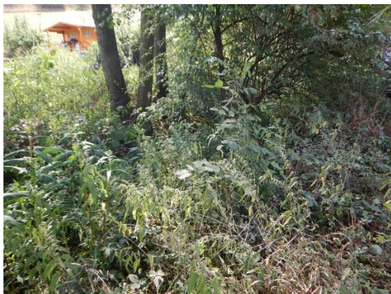
zarostlé koryto Přílepského potoka na okraji chatové zástavby
