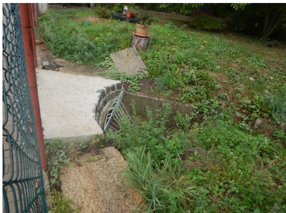
vtokový objekt na okraji zástavby
