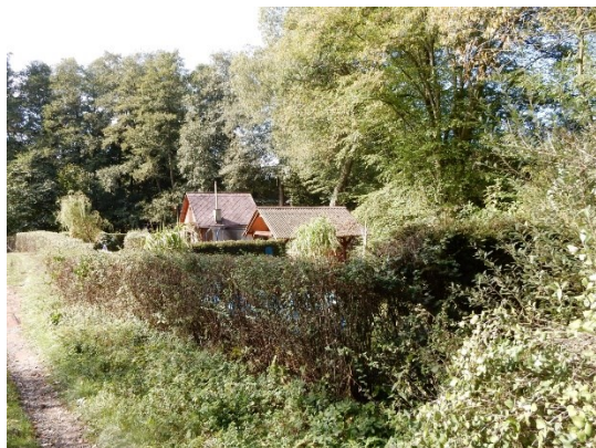
možná ohrožená zástavba v místě kritického bodu
