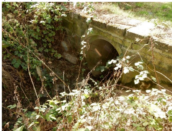
vtok do zatrubnění v místě kritického bodu
