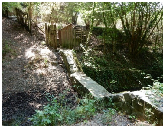
Přehrážka v místě kritického bodu
