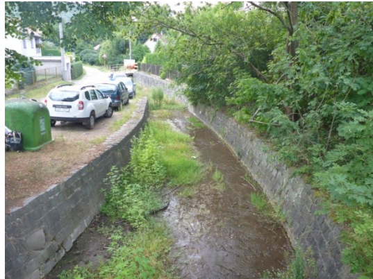
pohled po proudu pod kritickým bodem
