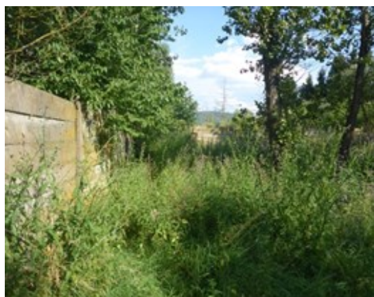
Oplocení betonovými panely pozemku s Lihovarským rybníkem
