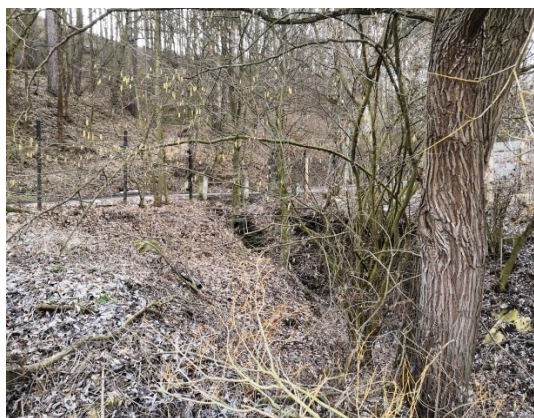
Křížení s ulicí Stradonická nad kritickým bodem
