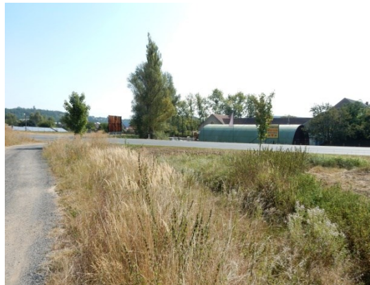
koryto vodního toku nad kritickým bodem
