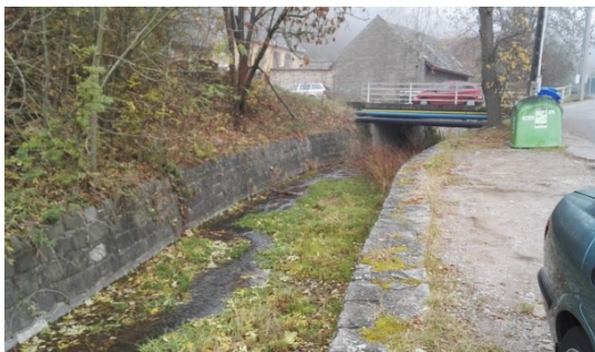
mostek pod kritickým bodem (pohled proti proudu)
