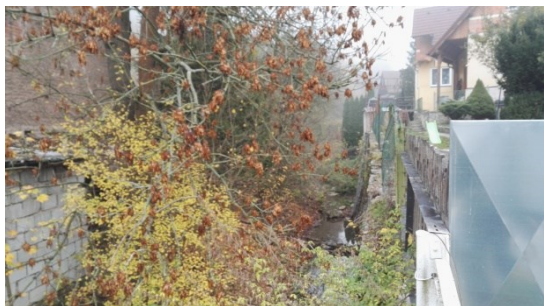
místo kritického bodu, zúžený profil a zástavba až k břehové hraně
