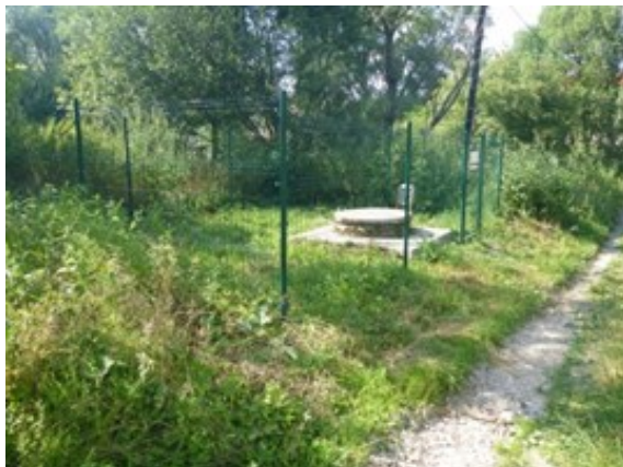
Vrt na pitnou vodu
