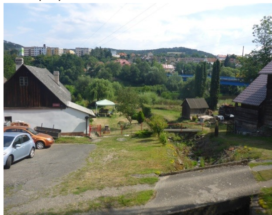
budova pod propustkem - potenciálně ohrožená budova
