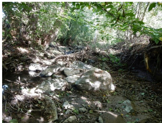
samovolná renaturace – narušení opevnění, zapojení vegetace
