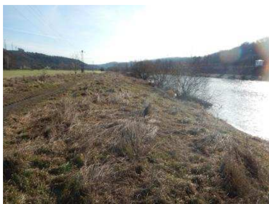
Detail břehové hrany
