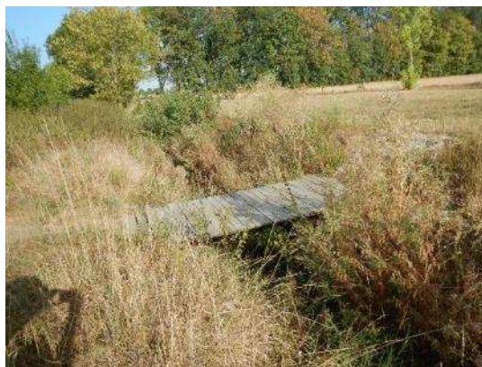
Charakteristický úsek v extravilánu u Ptice
