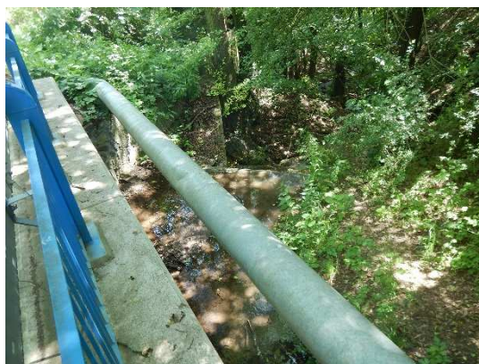
Pohled na úsek toku pod mostem
