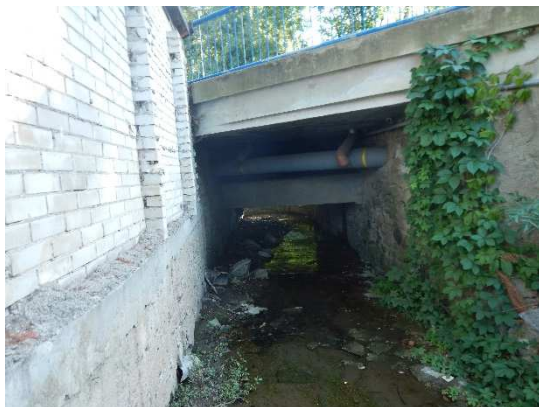
Mostní profil v ř. km 0,45
