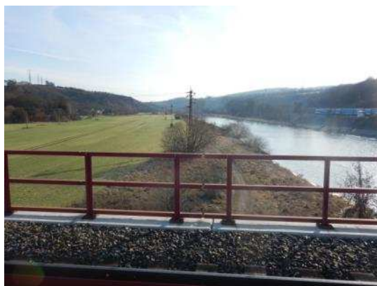
Pohled směrem po toku z železničního mostu (levý břeh)
