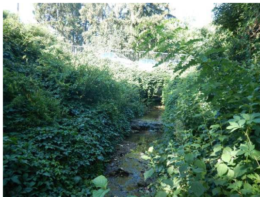
Mostní profil v ř. km 0,59
