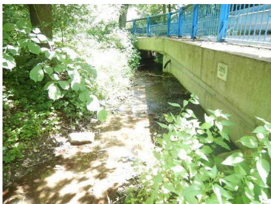
Mostní objekt na toku nad obcí Karlík
