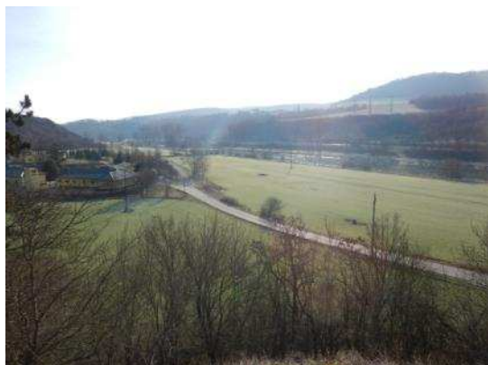
Pohled na levobřežní bermu u ČOV Beroun
