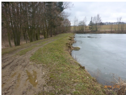
Vodní nádrž nad Panoším újezdem
