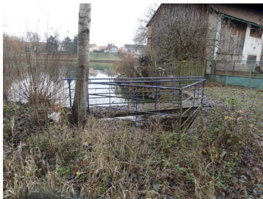
Zástavba přímo na břehu rybníka, u bezpečnostního přelivu
