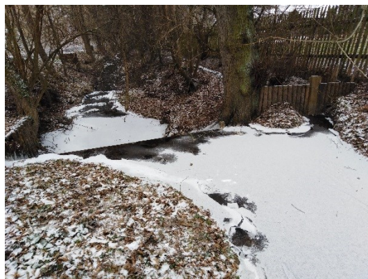
Stůp a náhon s hradítkem pohled po proudu
