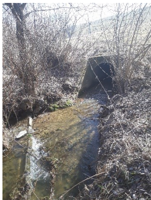
Vtok do zatrubnění v louce pod obcí
