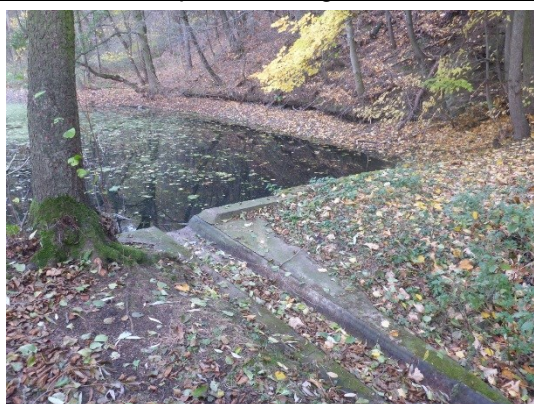
Bezpečnostní objekt na hrázi rybníka
