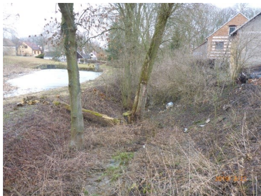
Koryto pod propustkem
