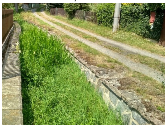
Opevněné obdélníkové koryto
