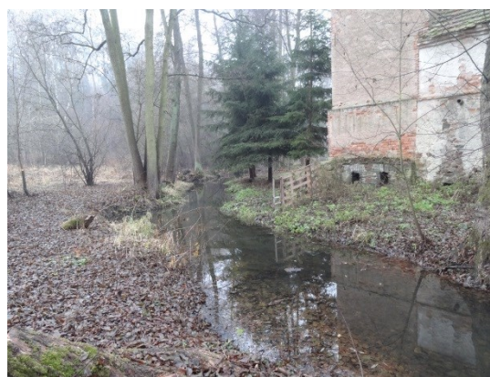
Jedna z budov je téměř na břehové hraně
