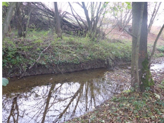
Nátrže na vodním toku
