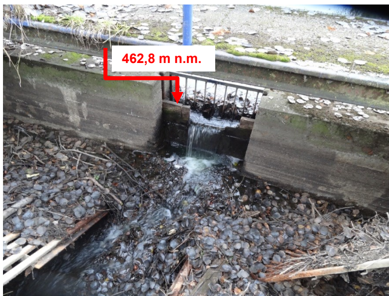
Obr. 12: Detail stávajícího bezpečnostního přelivu na Hradeckém rybníku
