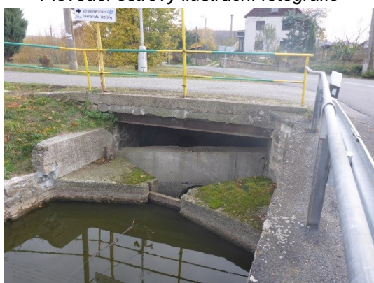
Stávající objekt BP
