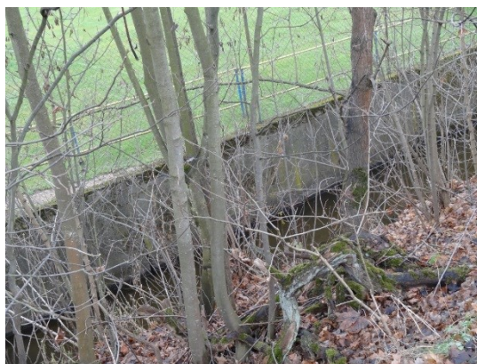
Detail betonové zdi na pravém břehu vedle fotbalového hřiště
