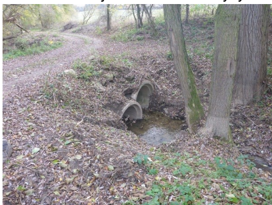
Propustek na konci úseku
