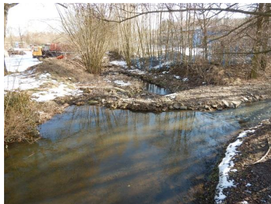
Improvizovaný rozdělovací objekt nad průmyslovým areálem v Bohutíně
