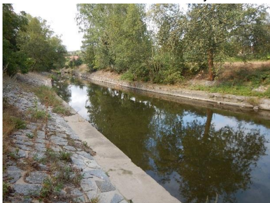
Tvrdé opevnění Litavky u Jinců
