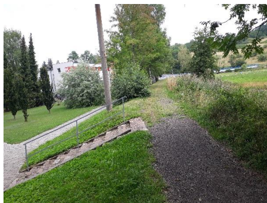
Pohled na korunu hráze, vzdušní líc, v pozadí budova obecního úřadu
