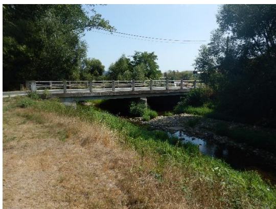
Silniční most v obci se středním pilířem
