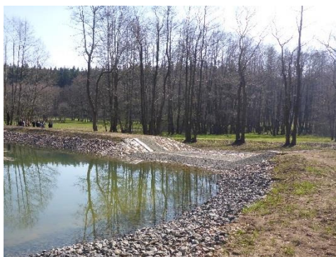
Obr. 62: Příklad vhodného řešení bezpečnostního přelivu formou opevněného průlehu
