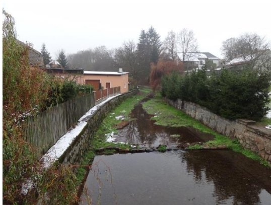
Koryto nad mostem, pohled proti proudu
