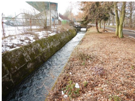
Opět velmi tvrdé opevnění podél stadionu
