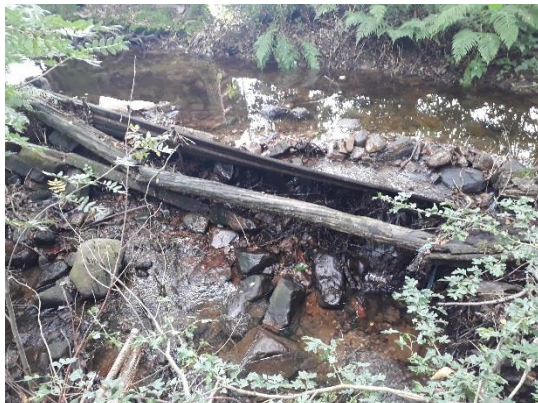
Místa na pravém břehu toku určená pro převod vody do Mourového potoka u stavidla nad Novou Vsí, formováno při průchodu každé větší vody. V současné době jsou plechy podemlety a voda protéká pod nimi.
