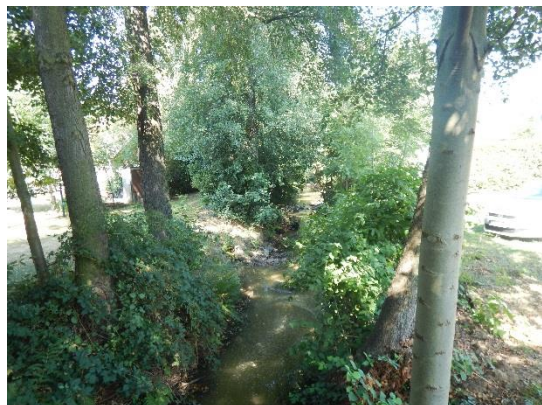
Přírodnější úsek pod VD Zásalská
