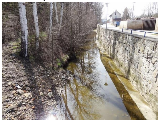
Stávající opevnění pod Žebráckým r.
