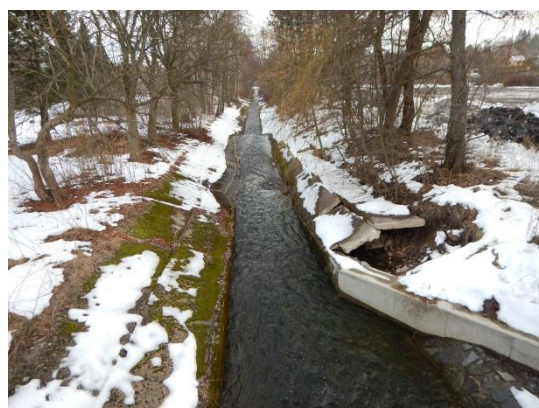
Tvrdá stabilizace pod fotbalovým stadionem (vpravo viditelný prvek rekonstrukce mostu)
