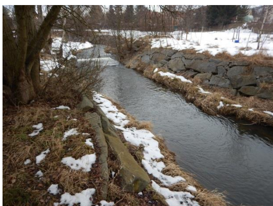
Stabilizace břehů kamennou rovnatinou
