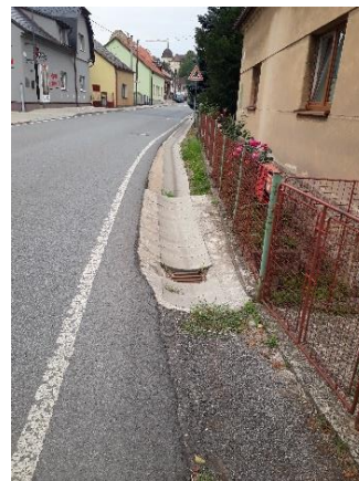
Obr. 55: příkop u jižního okraje mostu
