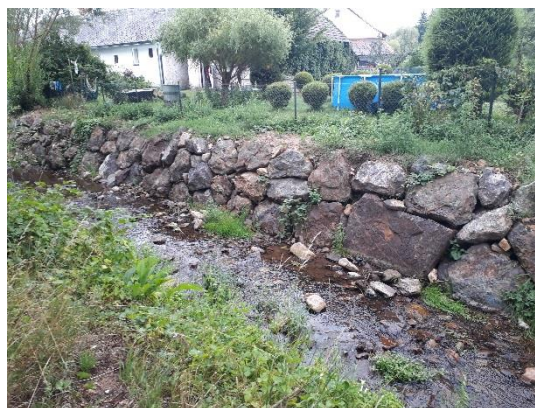
Provizorní oprava koryta nad ústím do Jalového potoka, pohled proti proudu (červenec 2019)
