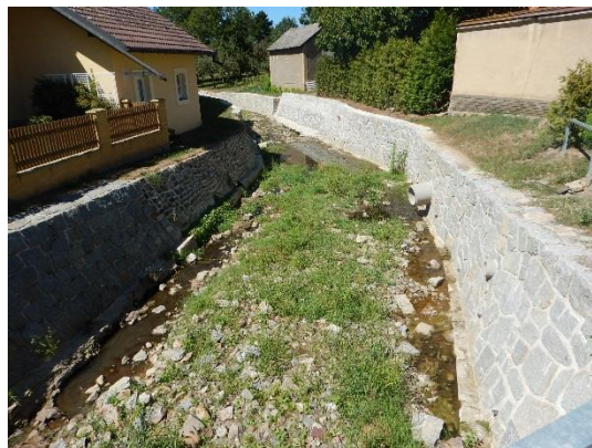
Intravilánová úprava koryta v Hostomicích
