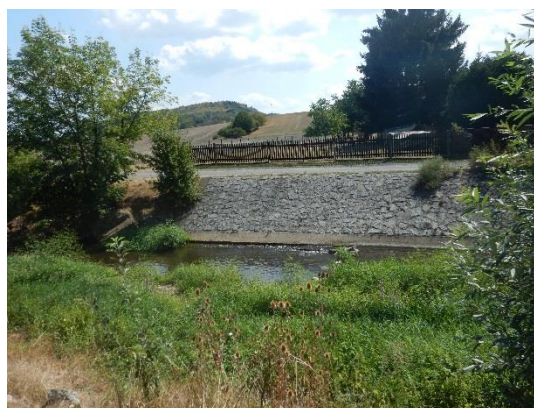
Intravilánový úsek v obci Praskolesy
