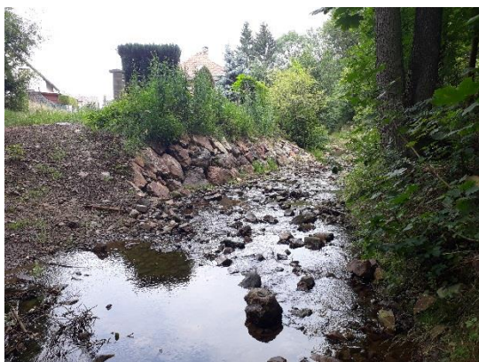
Provizorní oprava koryta v horní části úseku, cca ř. km 1,135, pohled po proudu (červenec 2019)
