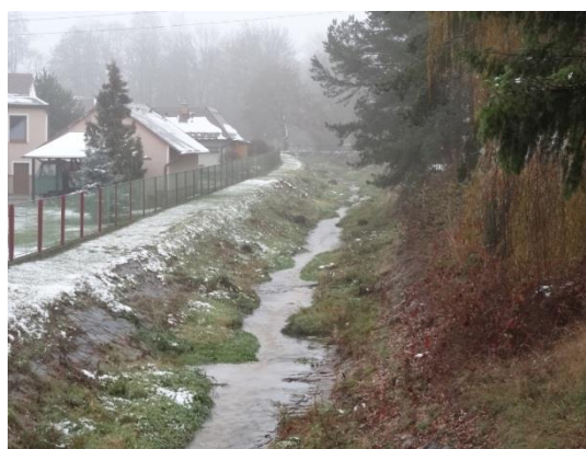
Pohled z mostu na severu obce proti proudu, na pravém břehu ohrožená zástavba – navrhuje se zvýšit podezdívky plotů
