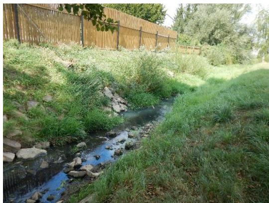
Intravilánový úsek s šikmými břehy
