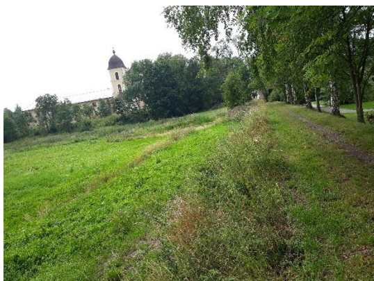
Vlevo prostor zátopy, vpravo koruna hráze, v pozadí klášter
