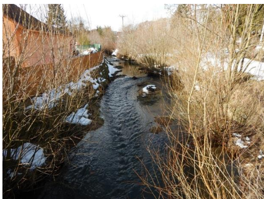
Koryto nad rozdělovacím objektem
