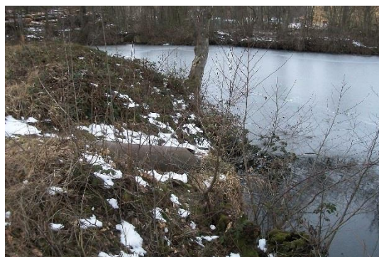
Obr. 63: Bezpečnostní přeliv řešený trubkou DN 600 (vlevo nátok, vpravo výtok)
