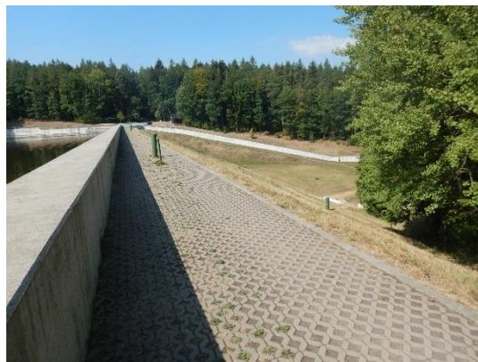
Těleso hráze VD Zásalská
