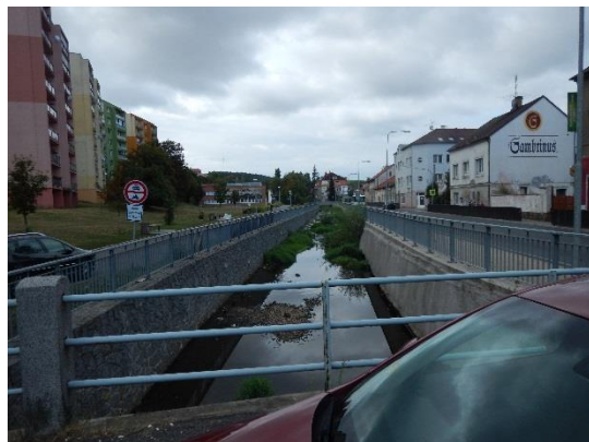
Intravilánový úsek toku v obdélníkovém korytě
