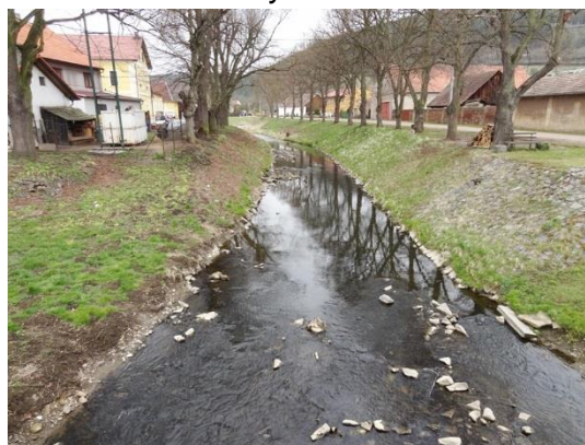
Intravilánový úsek v obci Hředle
