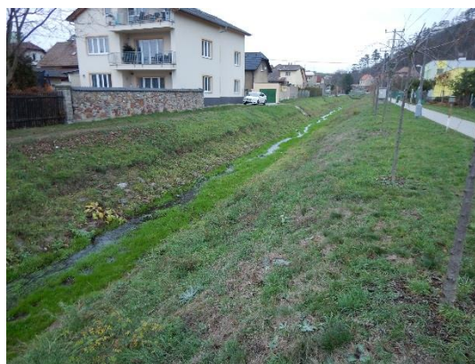
Úsek toku lichoběžníkového tvaru koryta
