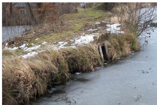
Obr. 63: Bezpečnostní přeliv řešený trubkou DN 600 (vlevo nátok, vpravo výtok)
