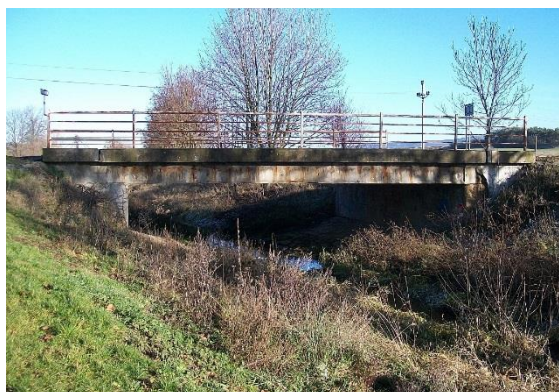
Pohled na předmětný mostní objekt
