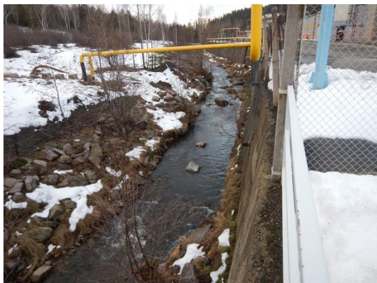
Jednostranná úprava svislou zdí ze strany areálu Kovohutí
