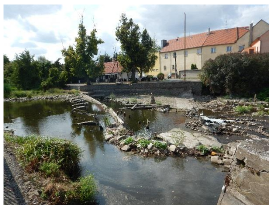
Pohled na „odplavený“ jez z PB
