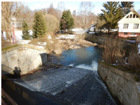
Pohled z hráze Vysokopeckého rybníka v místě bezpečnostního přelivu
