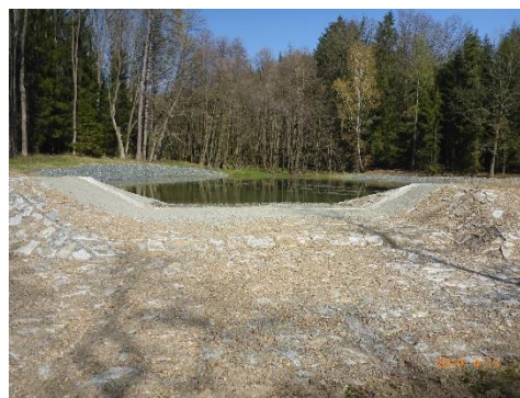
Obr. 62: Příklad vhodného řešení bezpečnostního přelivu formou opevněného průlehu
