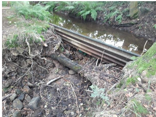
Místa na pravém břehu toku určená pro převod vody do Mourového potoka u stavidla nad Novou Vsí, formováno při průchodu každé větší vody. V současné době jsou plechy podemlety a voda protéká pod nimi.
