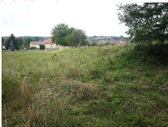
Pohled na vzdušný líc bývalé hráze (na severu nádrže)
