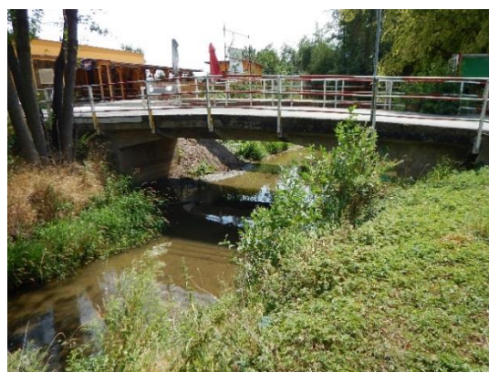
Mostní objekt v intravilánu Nenačovic
