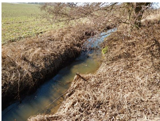
Nad silnicí je koryto již mělčí, resp. není tak zahloubeno jako pod silnicí
