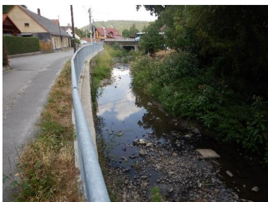
Pohled na PB nad VN Laskavec (v pozadí silniční most na hlavní komunikaci)
