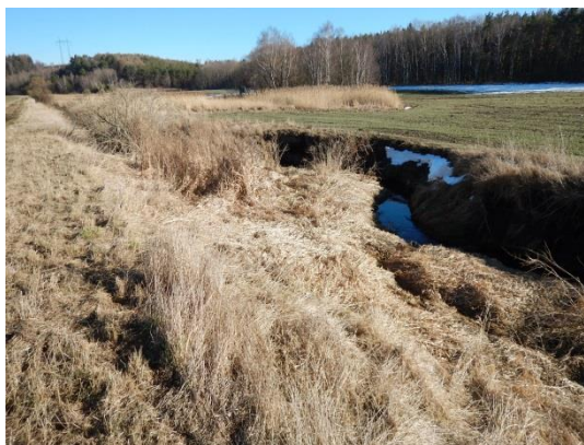
Úsek pod revitalizací se vyznačuje velkým zahloubením a výraznou boční erozí
