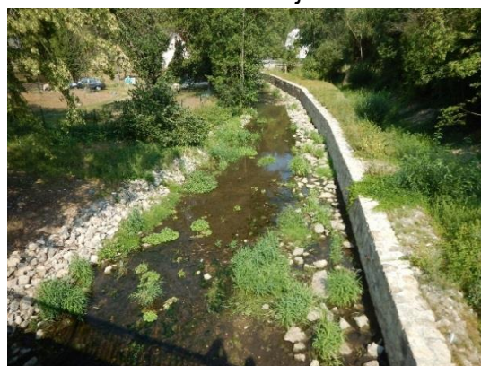
Úprava koryta nad mostem (mimo SO)
