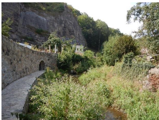
Pohled na řešený úsek v obci pod sil. mostem
