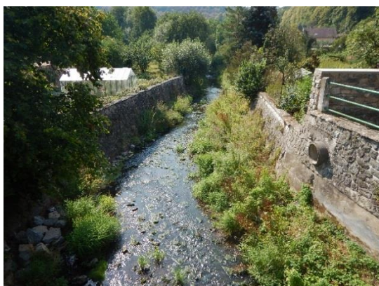
Vysoké zdi pod silničním mostem
