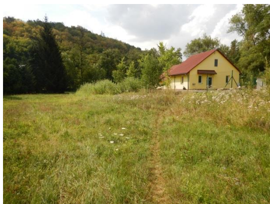
ČOV pod obcí Loděnice – Jánská
