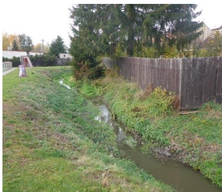
Stávající koryto, složený lichoběžníků Obr. 48: Zkapacitnění toku SO 02.5.4a
