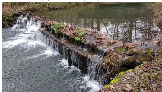
Detail jezu (stupně)
