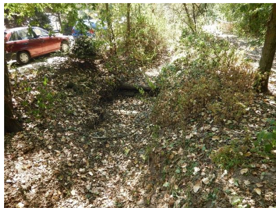
Dřevěný stupeň na dolním toku
