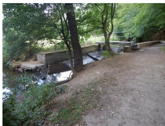
Rozdělovací objekt náhonu u hřiště
