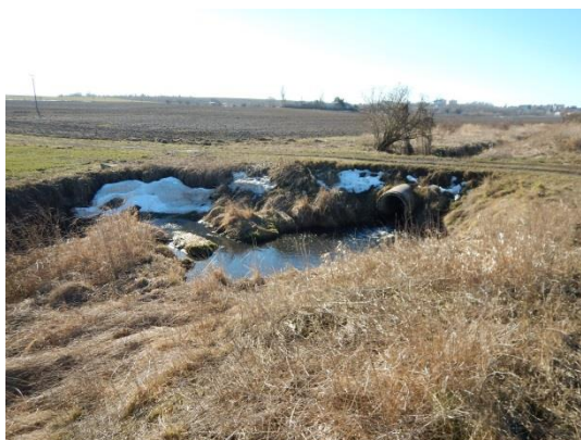
Detailní pohled na propustek (nad propustkem je plánována na LB nová ČOV)
