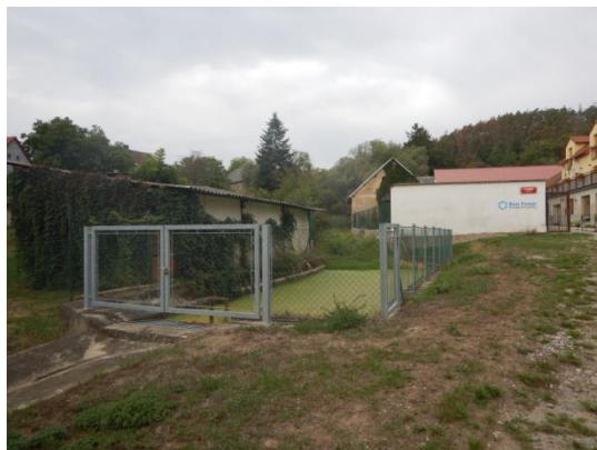
Nádrž na vtoku hlavního z přítoku do zatrubněného úseku v intravilánu obce
