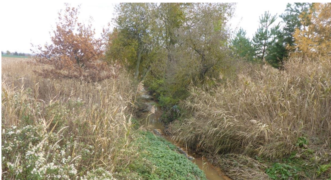
Stávající koryto v lokalitě ČOV, pohled po proudu Obr. 51: Fotodokumentace SO 02.5.5 – Revitalizace ČOV
