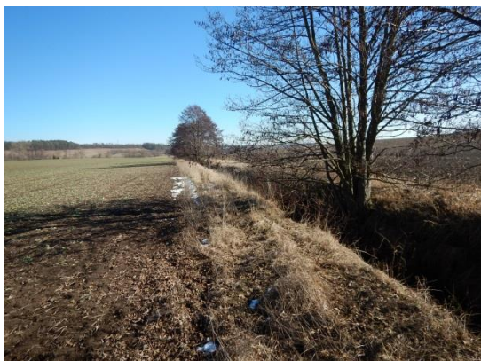
Napřímené a zahloubené koryto pod Stochovskou silnicí
