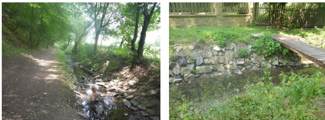
Obr. 4: fotodokumentace SO 02.1.2 obec Nižbor – koryto podél ul. V Hamburku
