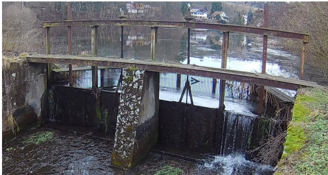
Obr. 10: Monstranský rybník – stavidlo bezpečnostního přelivu (25.2.2019)
