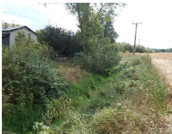
koryto Podlužského potoka pod profilem hráze
