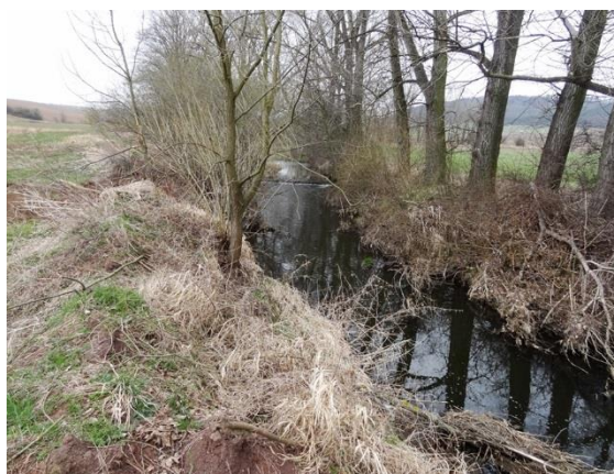
koryto Stroupinského potoka v profilu hráze
