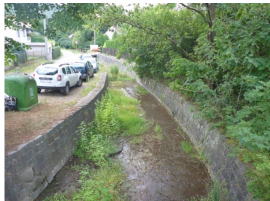
Pohled po proudu pod navrhovanou SN
