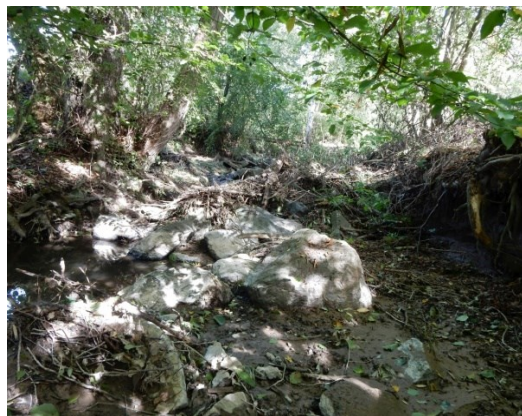
Samovolná renaturace - narušení opevnění, zapojení vegetace
