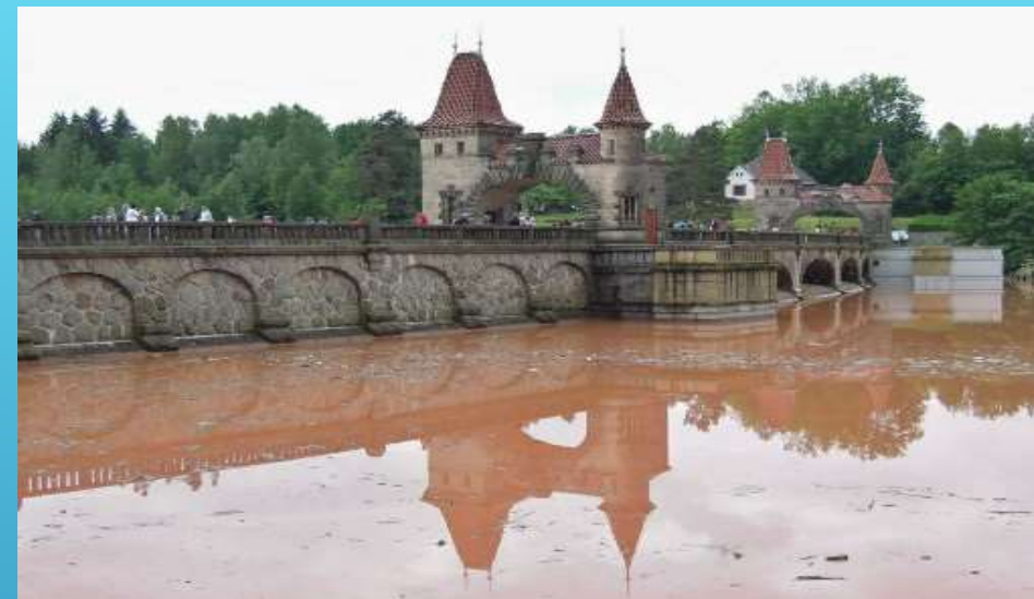
VD Les Království během povodně 6/2013 transformovalo povodňovou vlnu s kulminací Q_{100} na odtok Q_{5-10}
