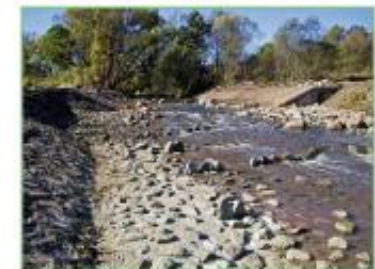
Dôležité detaily vnútra koryta bezprepážkového zdrsneného preliateho skúzu. Podstatou priechodnosti širokých skúzov pri extrémne malých pretekoch je trapezoidálny priečny profil, ktorý stavbári dosiahli pomocou drevenej šablóny (bez zásahu biologického dozoru stavby atypické preliatie stredovej prúdnice nebolo). Foto: autor
